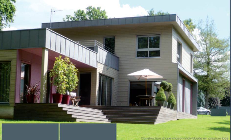
Construction d'une maison individuelle en ossature bois
