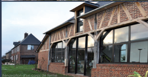
Rénovation d'un corps de ferme
