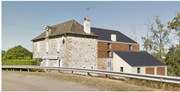
Extension d'une maison d'habitation – St-germain-les-Vergnes (19)
