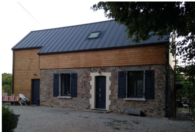
Extension d'une maison d'habitation – Seilhac (19)
