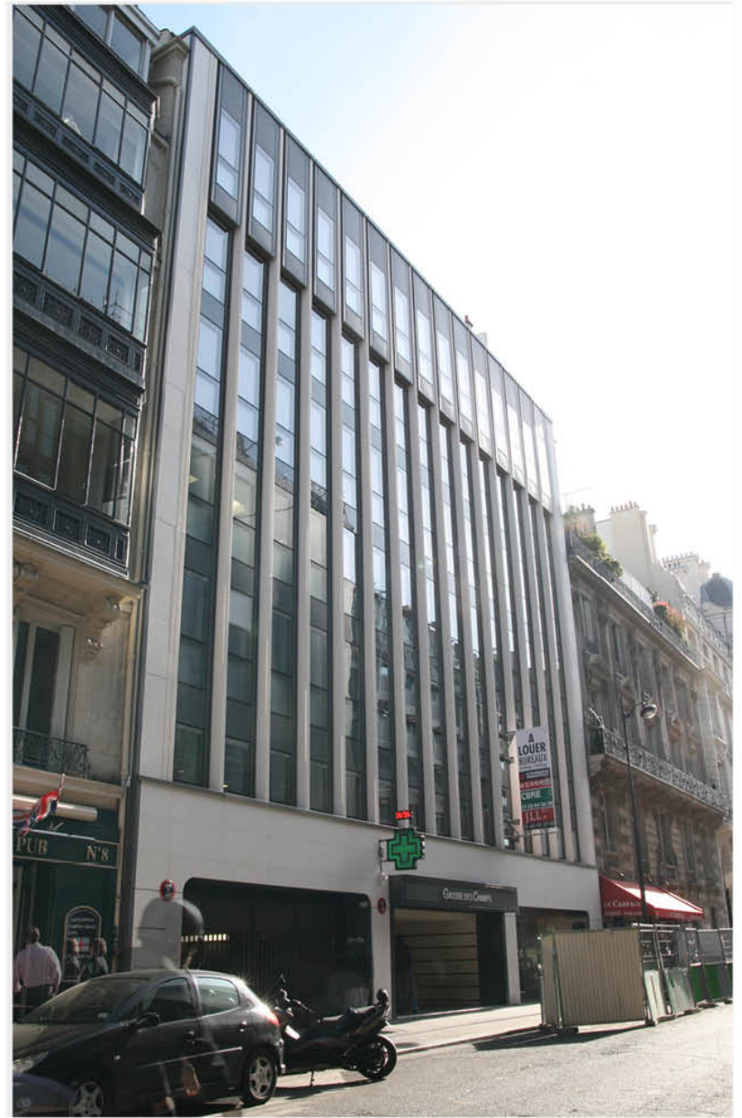
ADYAL - Rénovation et accessibilité des parties communes d'un immeuble
