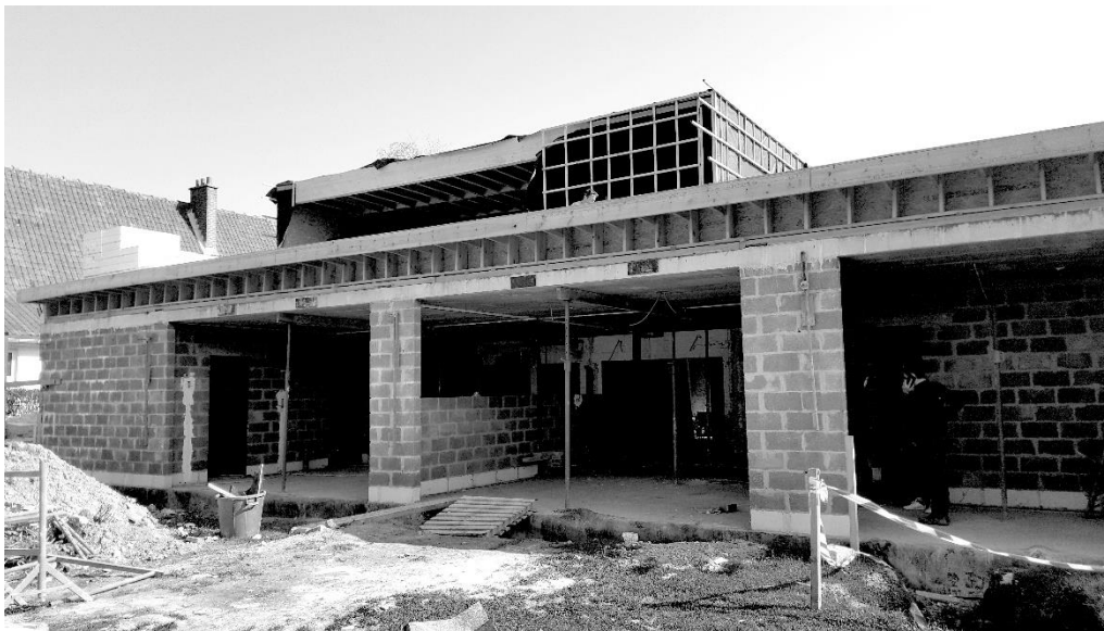
Façade arrière avant-travaux 3,
