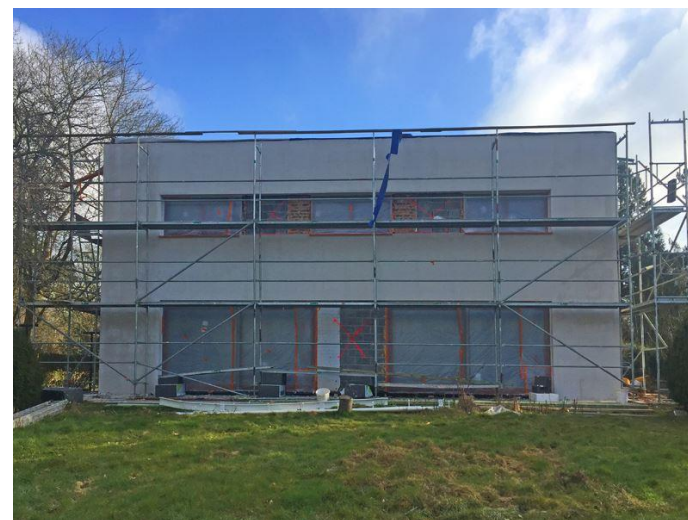
Situation pendant-travaux Façade arrière
