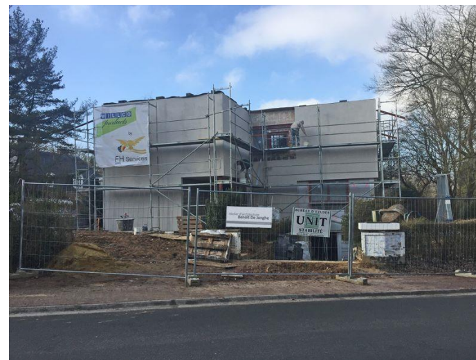
Situation pendant-travaux Façade avant
