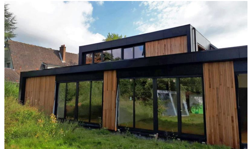
Façade arrière en fin de chantier
