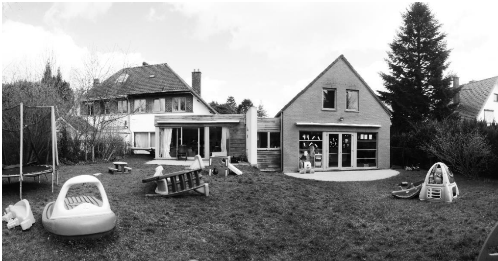
Façade arrière avant-travaux 1,
