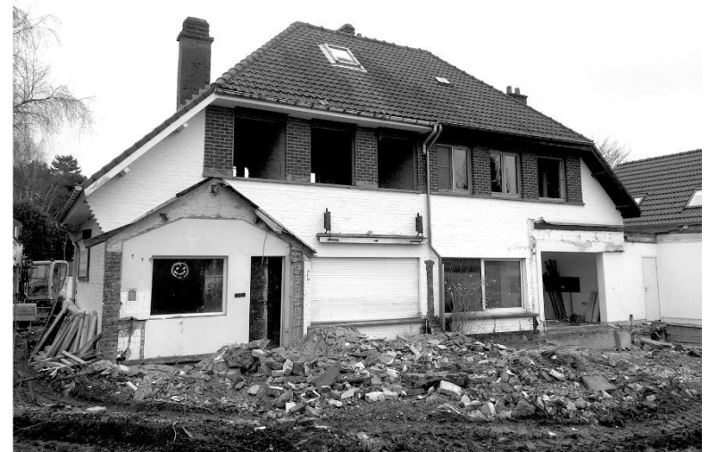
Façade arrière avant-travaux 2,
