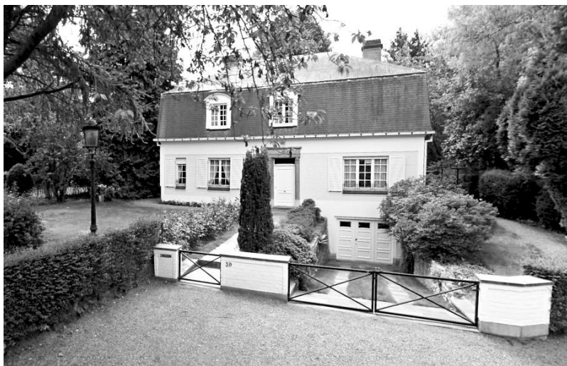
Situation avant-travaux Façade avant
