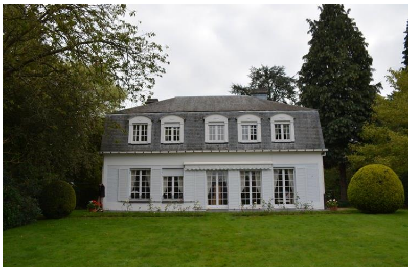
Situation avant-travaux Façade arrière
