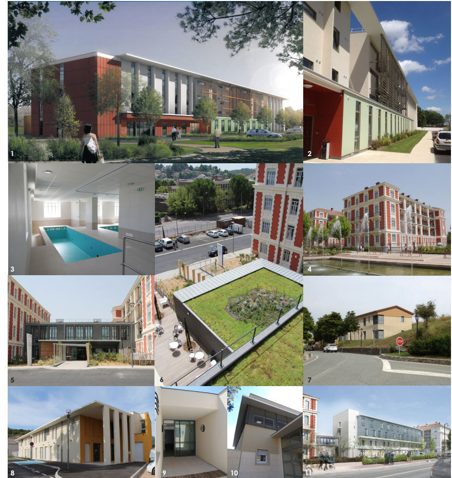
1_2. CLINIQUE PSYCHIATRIQUE, VILLEPINS 93. 3_4_5_6. CENTRE DE REEDUCATION FONCTIONNELLE, DRAGUIGNAN 83. 7. MAISON MEDICALE D'INTERET COMMUNAUTAIRE, COMPS SUR ARTUBY 83. 8_9. UNITE D'HOSPITALISATION EN PSYCHIATRIE CENTRE HOSPITALIER HENRI GUERIN, BRIGNOLES 83. 10. UNITE DE DIALYSE CENTRE HOSPITALIER JEAN MARCEL, BRIGNOLES 83. 11. CENTRE DE REEDUCATION FONCTIONNELLE LE BESSILLON, DRAGUIGNAN 83.
