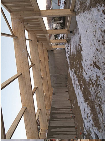
PHASE MONTAGE CHARPENTE BOIS
