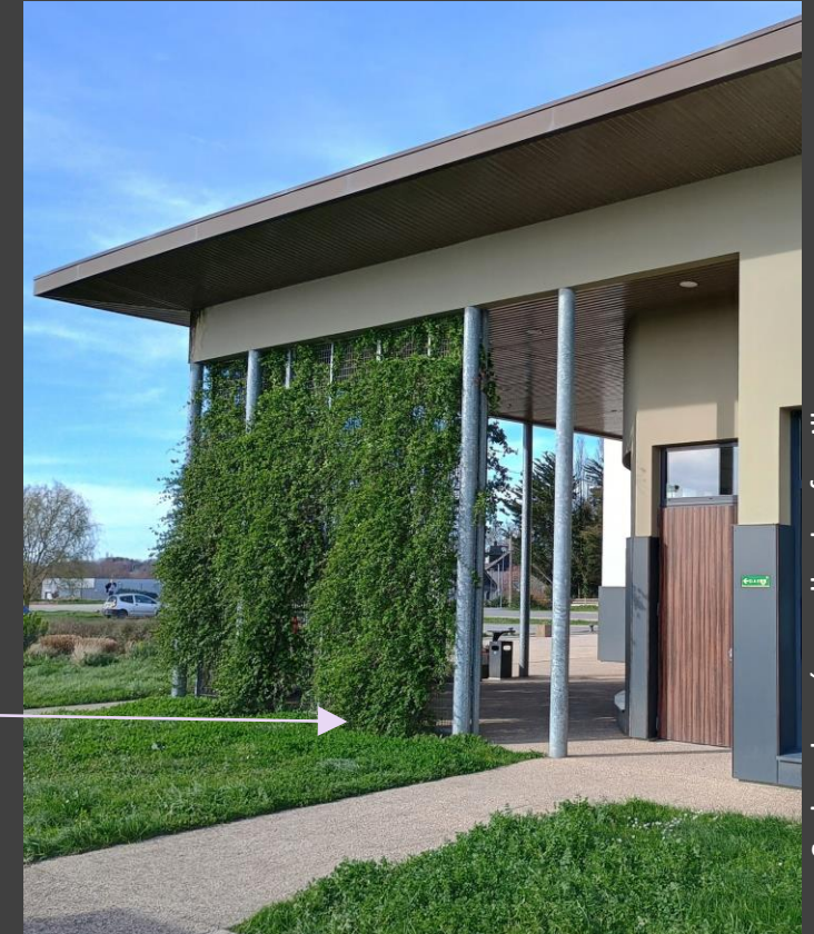
cour Sud ombragée - salle des familles
