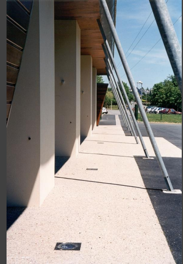
Protection solaire passive au Sud
