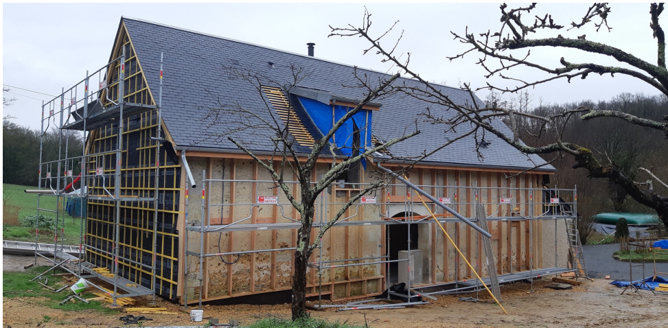
Isolation par l'extérieur en ouate de cellulose
