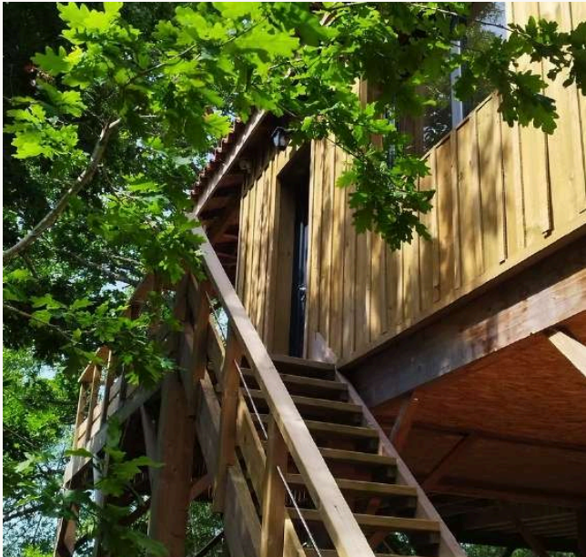
L'ESCALIER D'ACCÈS, À TROIS MÈTRES DU SOL
