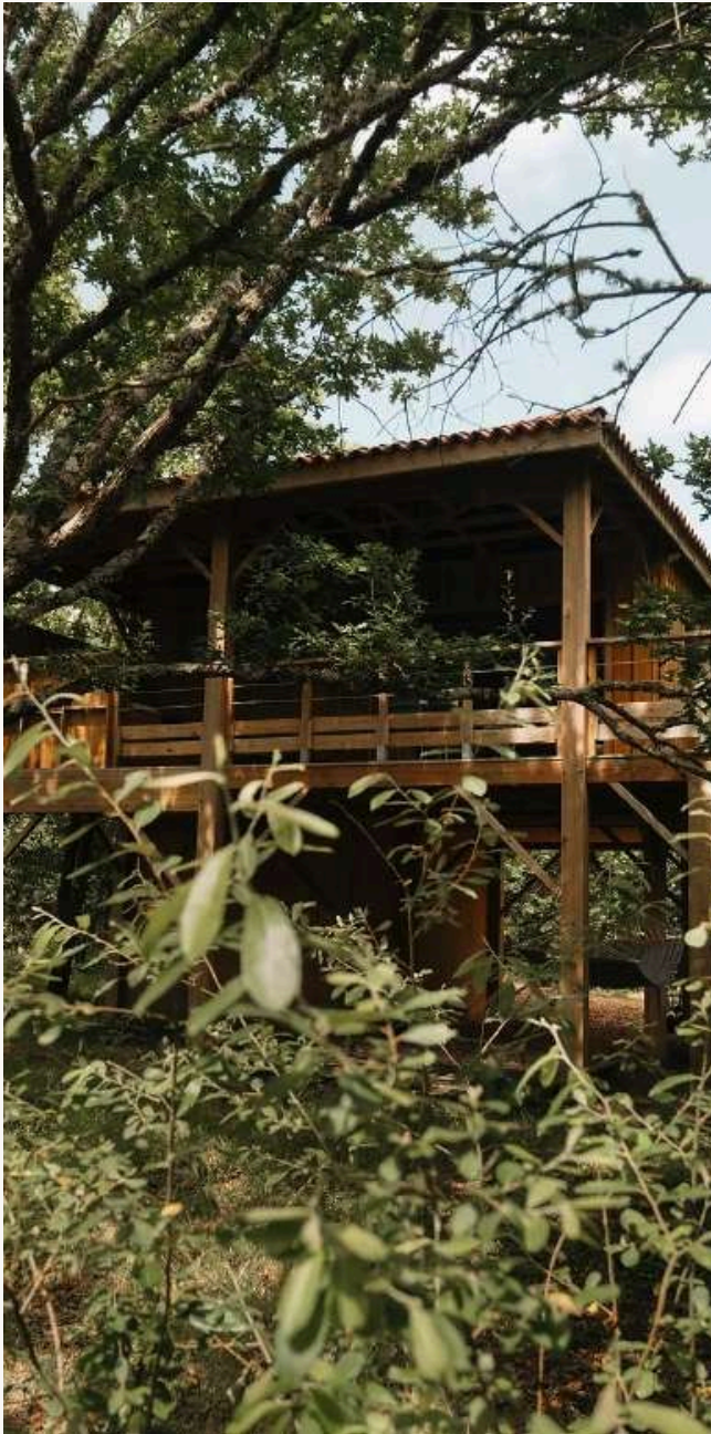
VUE DE LA CONSTRUCTION SUR PILOTIS
