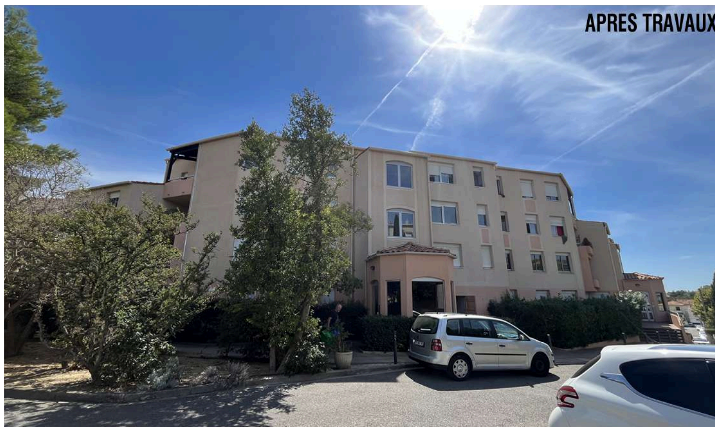
Vue vers la façade Nord, prise depuis l'entrée de la résidence.
