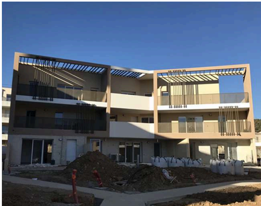
Vue vers la façade Sud du bâtiment B bis.
