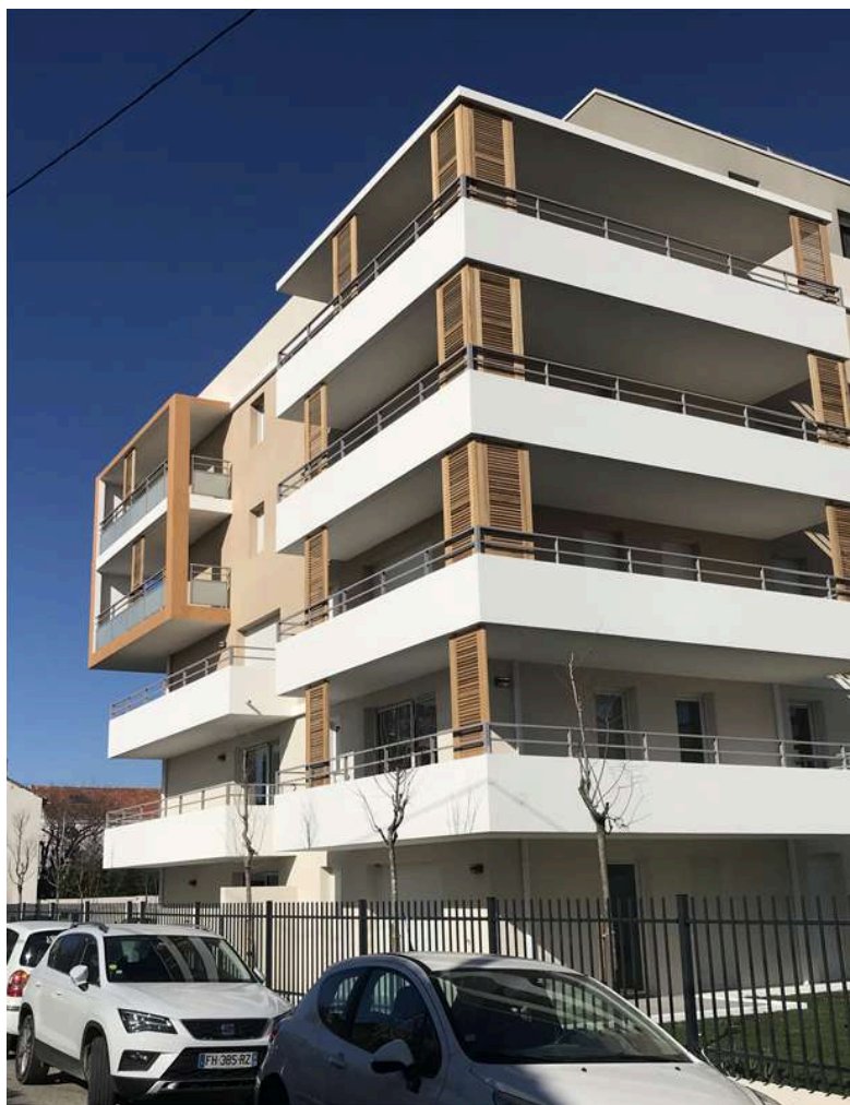
Vue vers l'angle Sud-Est, prise depuis le boulevard Cristol.
