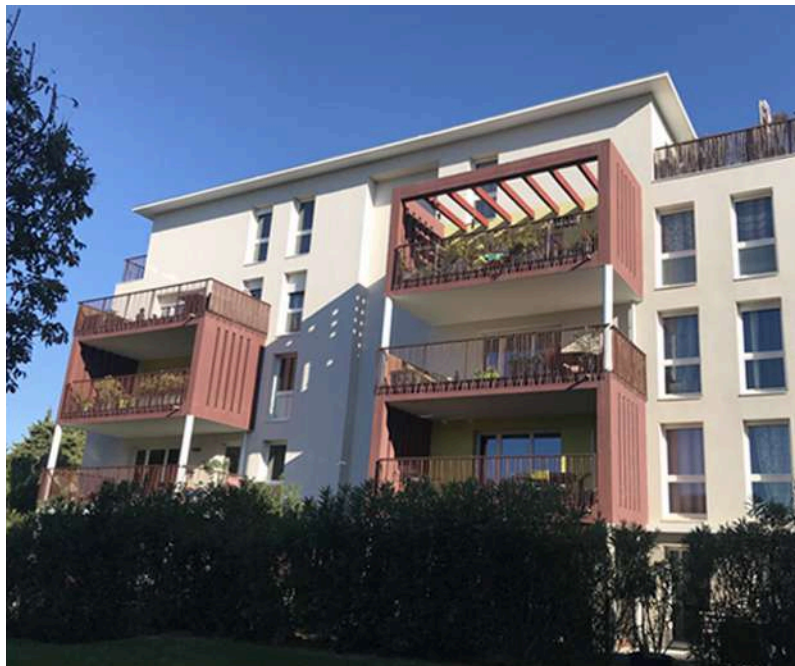
Vue vers la façade Ouest du bâtiment B2.
