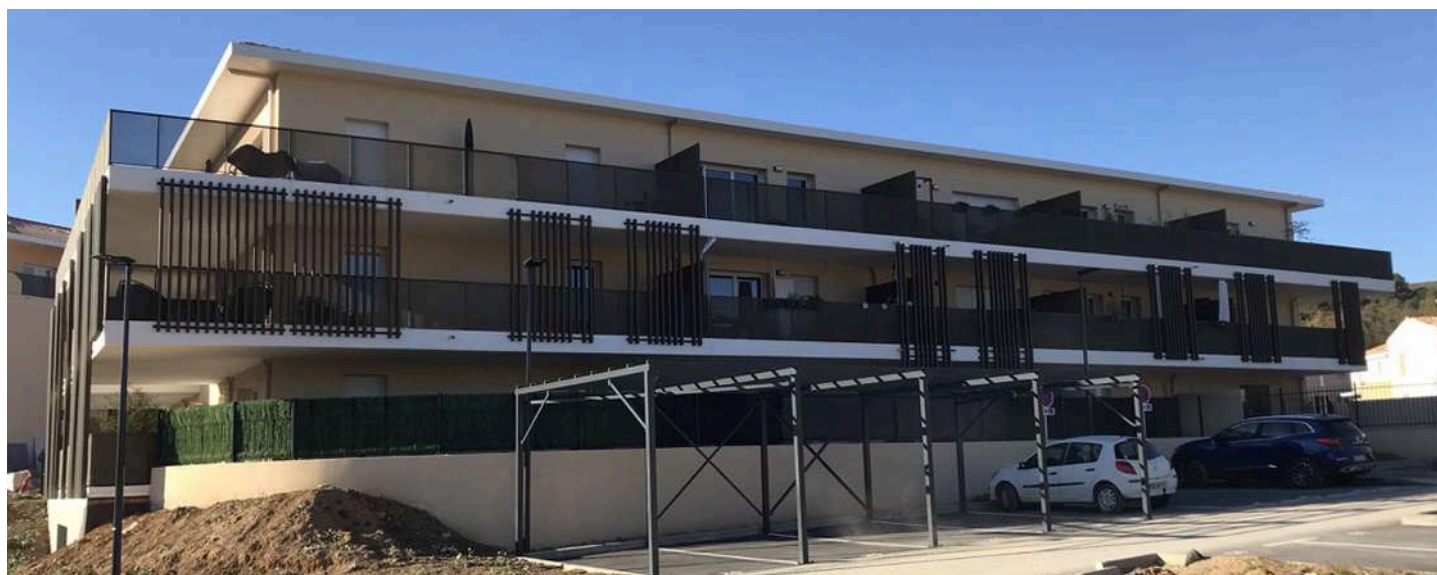
Vue vers la façade Est du bâtiment C.
