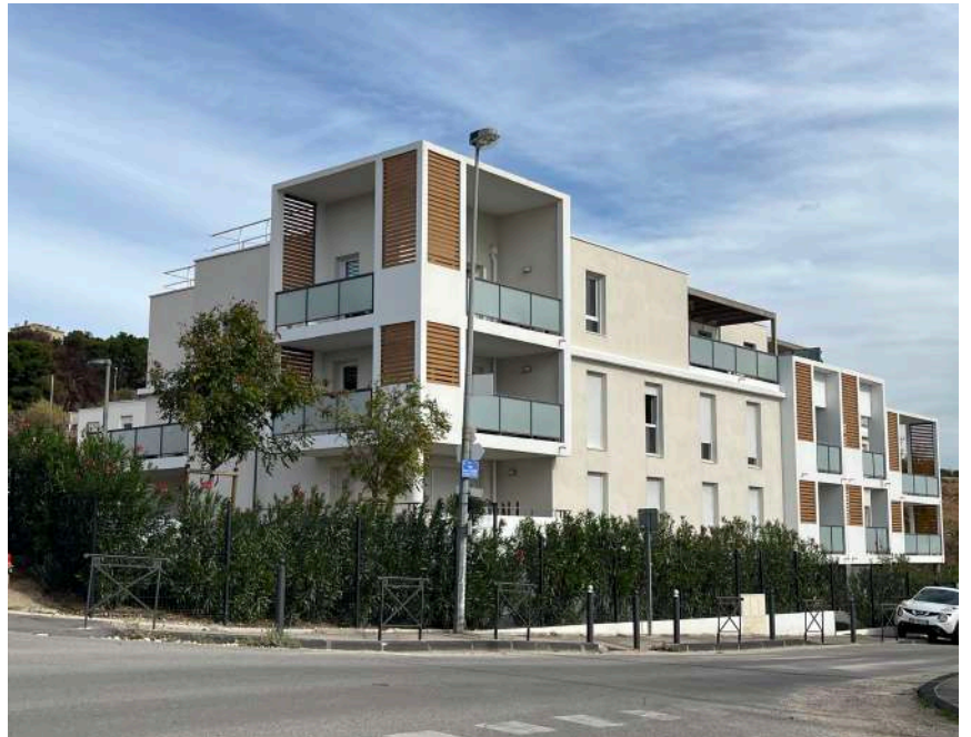
Vue vers l'angle Sud-Ouest du bâtiment A, prise depuis le croisement du chemin Gilbert Charmasson et de la rue Anne Gacon.
