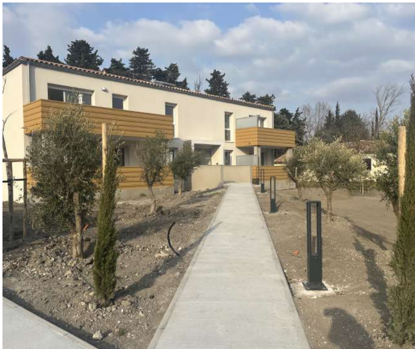
Vue vers la façade Sud du bâtiment D.
