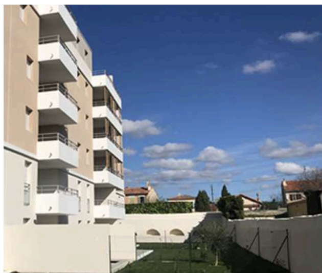
Vue vers la façade Est de la résidence.
