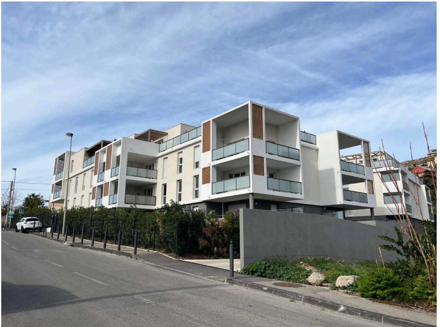
Vue vers les façades Sud et Est des bâtiments A et B, prise depuis la rue Anne Gacon.
