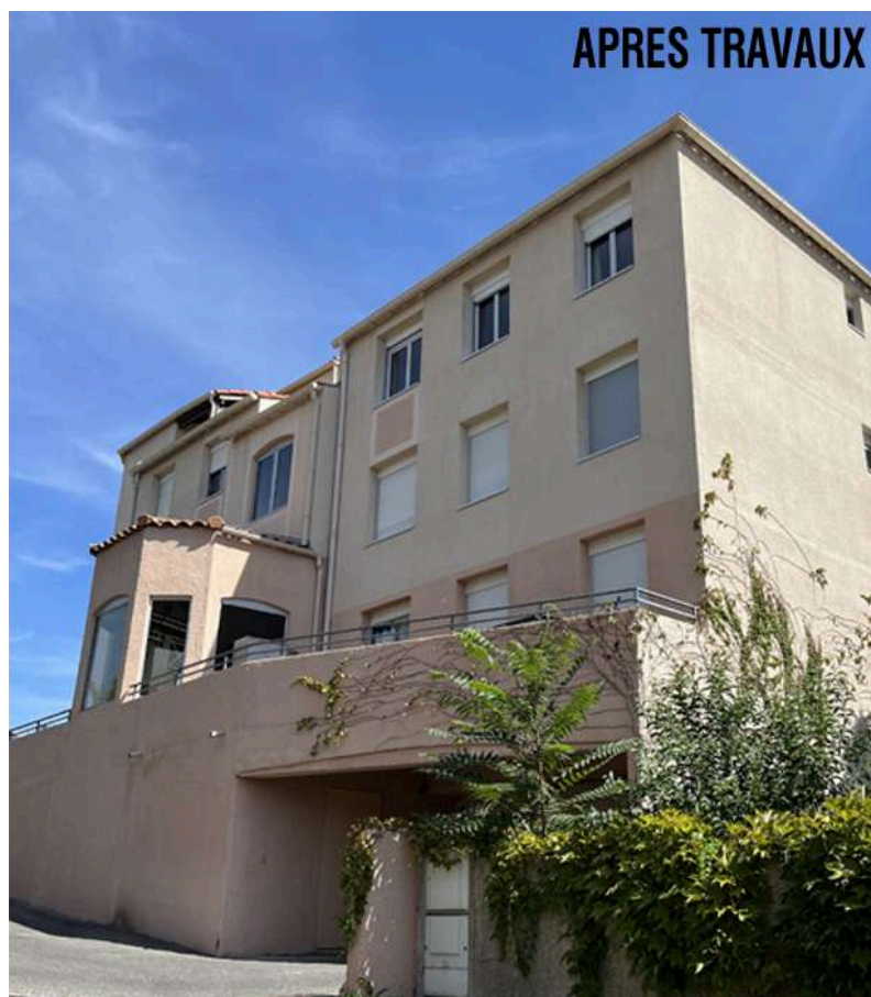
Vue vers la façade Ouest.
