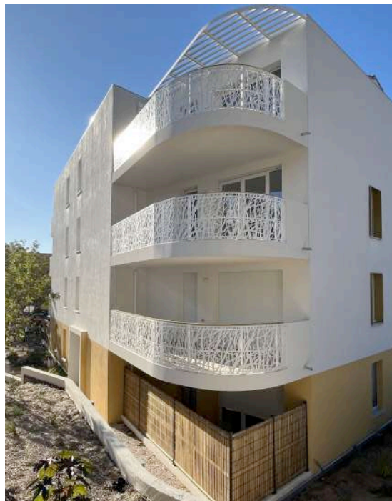
Vue vers l'angle Sud-Est et Nord-Est du bâtiment.
