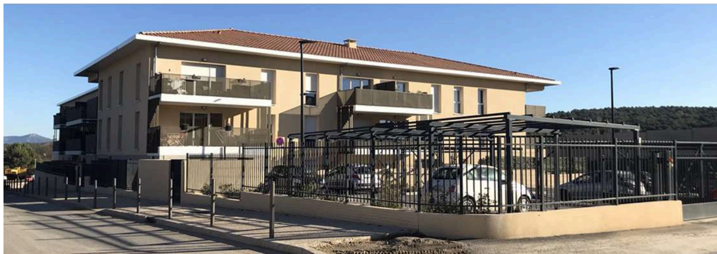
Vue vers les façades Nord et Ouest du bâtiment D, prise depuis le chemin des Bastidons.
