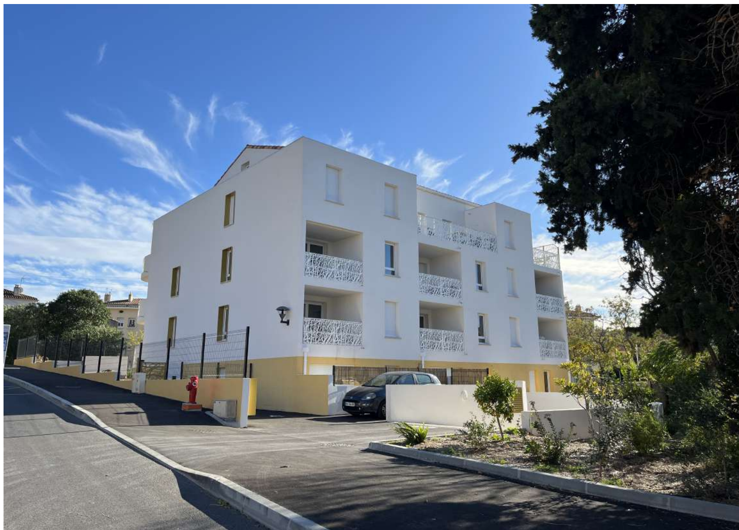
Vue vers les façades Nord-Est et Nord-Ouest, prise depuis l'avenue Charles Tournier.
