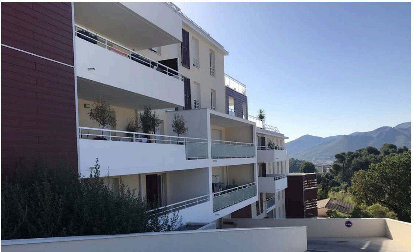
Vue vers la façade Ouest, prise depuis la rampe d'accès au sous-sol.
