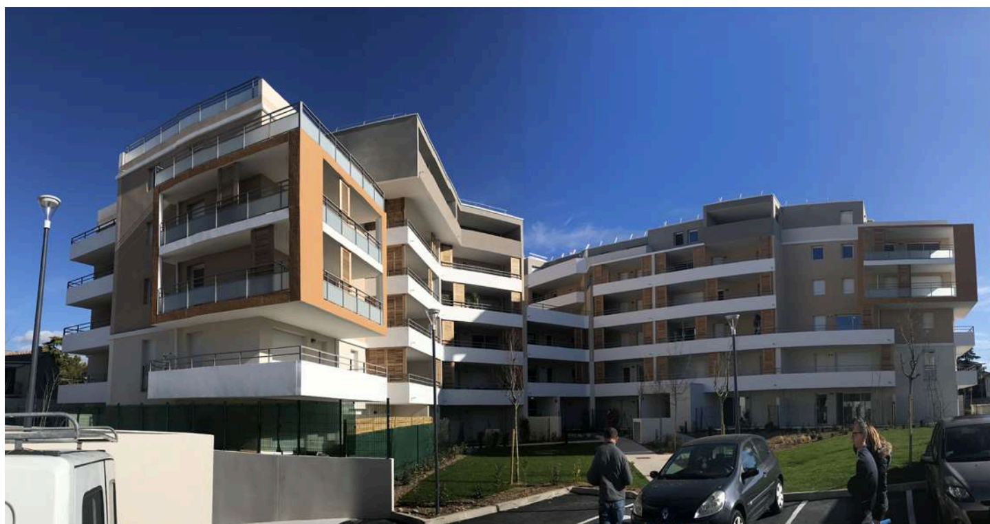
Vue vers les 3 entrées du bâtiment, prise depuis son parking extérieur.
