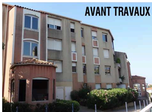
Vue vers la façade Nord, prise depuis l'entrée de la résidence.
