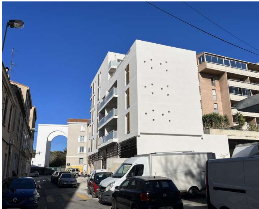
Vue vers l'angle Sud-Ouest de l'immeuble, prise depuis la rue Laugier.
