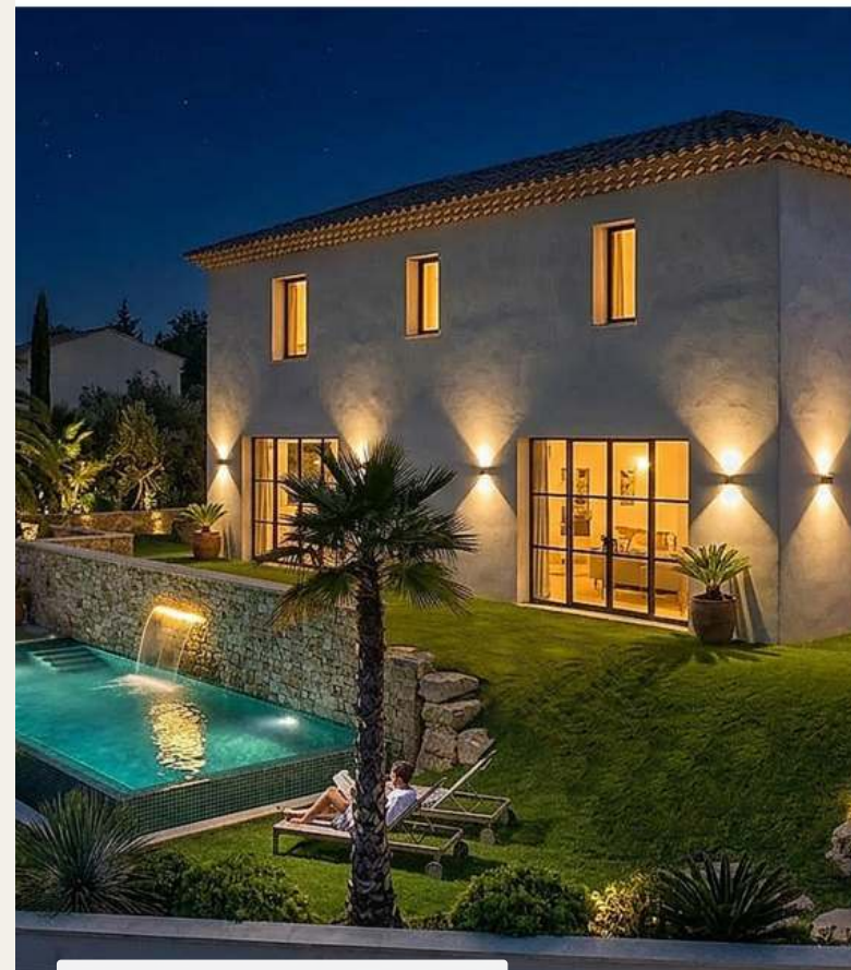
VILLA PRIVÉE - CARROS Mise en lumière extérieure
