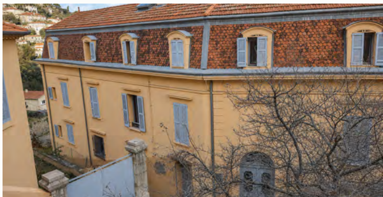
EXISTANT · AVANT TRAVAUX
