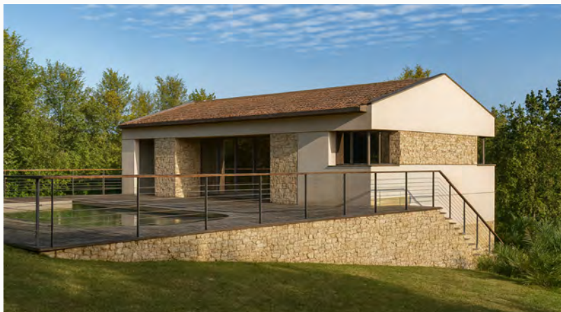
TOITURE · TERRASSE · PHOTOVOLTAÏQUE
