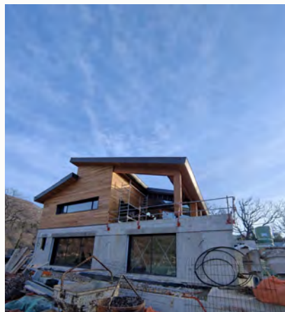
CHANTIER · STRUCTURE BOIS
