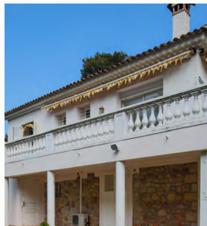
EXISTANT · FAÇADE LATÉRALE
