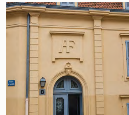
ENTRÉE · DÉTAIL PATRIMONIAL
