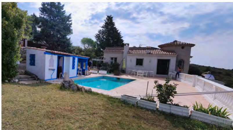
EXISTANT · AVANT TRAVAUX
