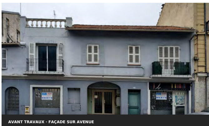
AVANT TRAVAUX · FAÇADE SUR AVENUE
