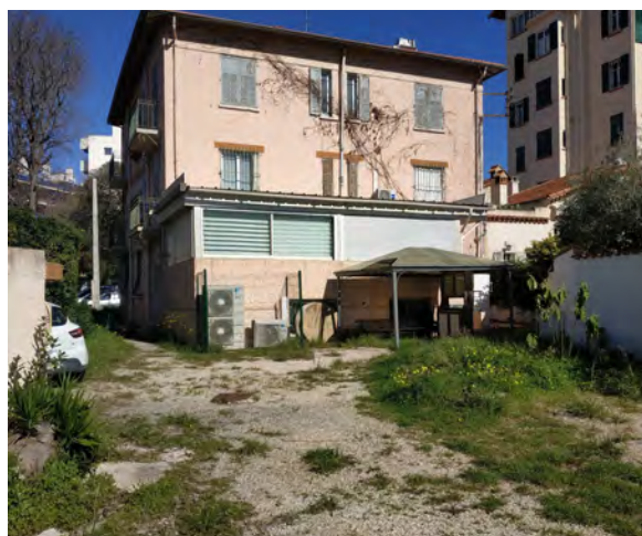
ÉTAT EXISTANT · BÂTIMENT FRAPPÉ D'UN ARRÊTÉ DE PÉRIL
