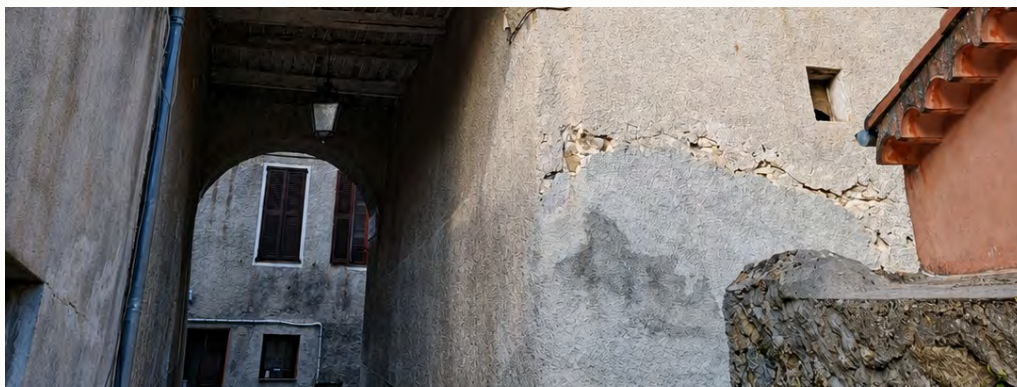
PASSAGE VOÛTÉ · CONTINUITÉ DES CHEMINEMENTS
