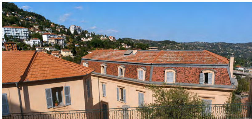
SITE · TOITURES ET PAYSAGE GRASSOIS
