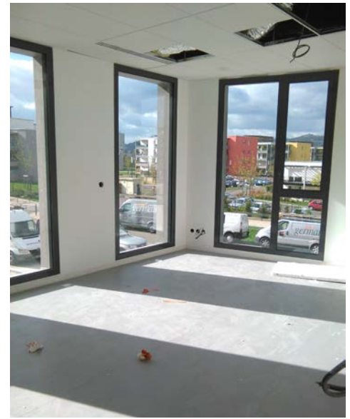
▲ Vue du lot 9A (chantier)
