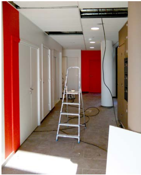
▲ Zone accueil (chantier)
