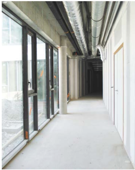
▲ Vue du patio vers lot 5A (chantier)
