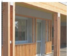
Poteau bois moisé
