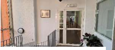
Vue accès depuis hall à extérieur des locaux
