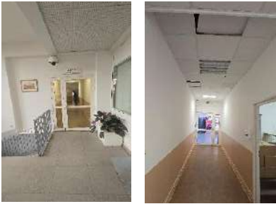
Vue accès depuis hall à extérieur des locaux
