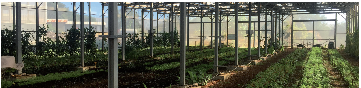
photo d'ombrières existantes
