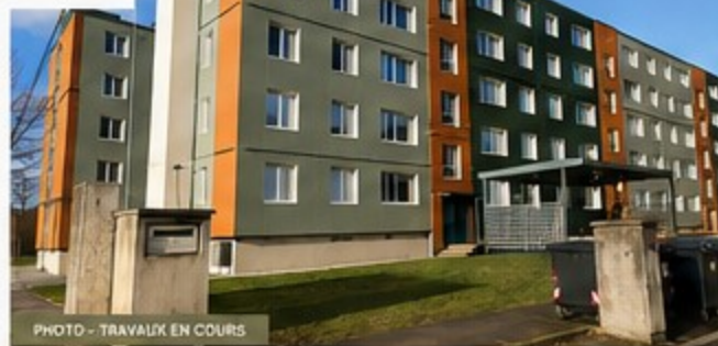
PHOTO - TRAVAUX EN COURS
