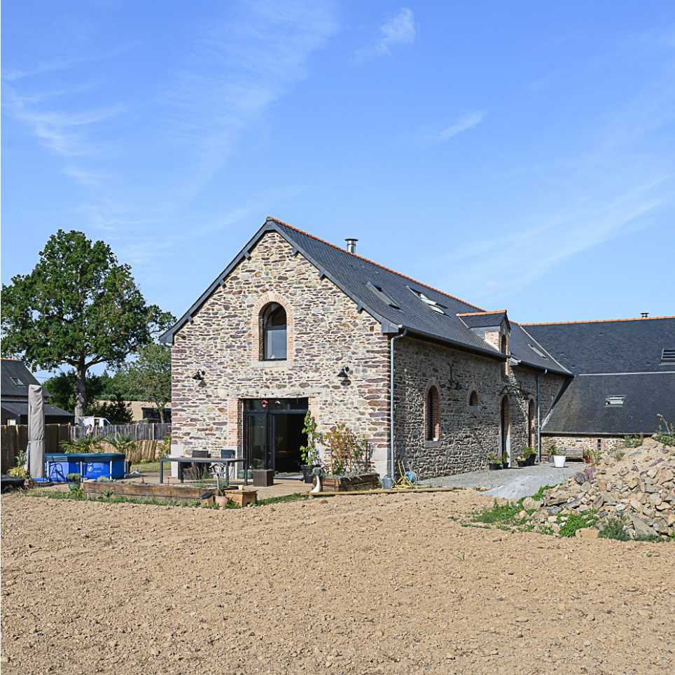
PHOTOGRAPHIE APRES TRAVAUX . PIGNON EST
