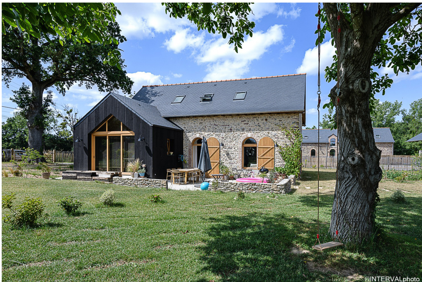
PHOTOGRAPHIE ; MAISON FAÇADE SUD
