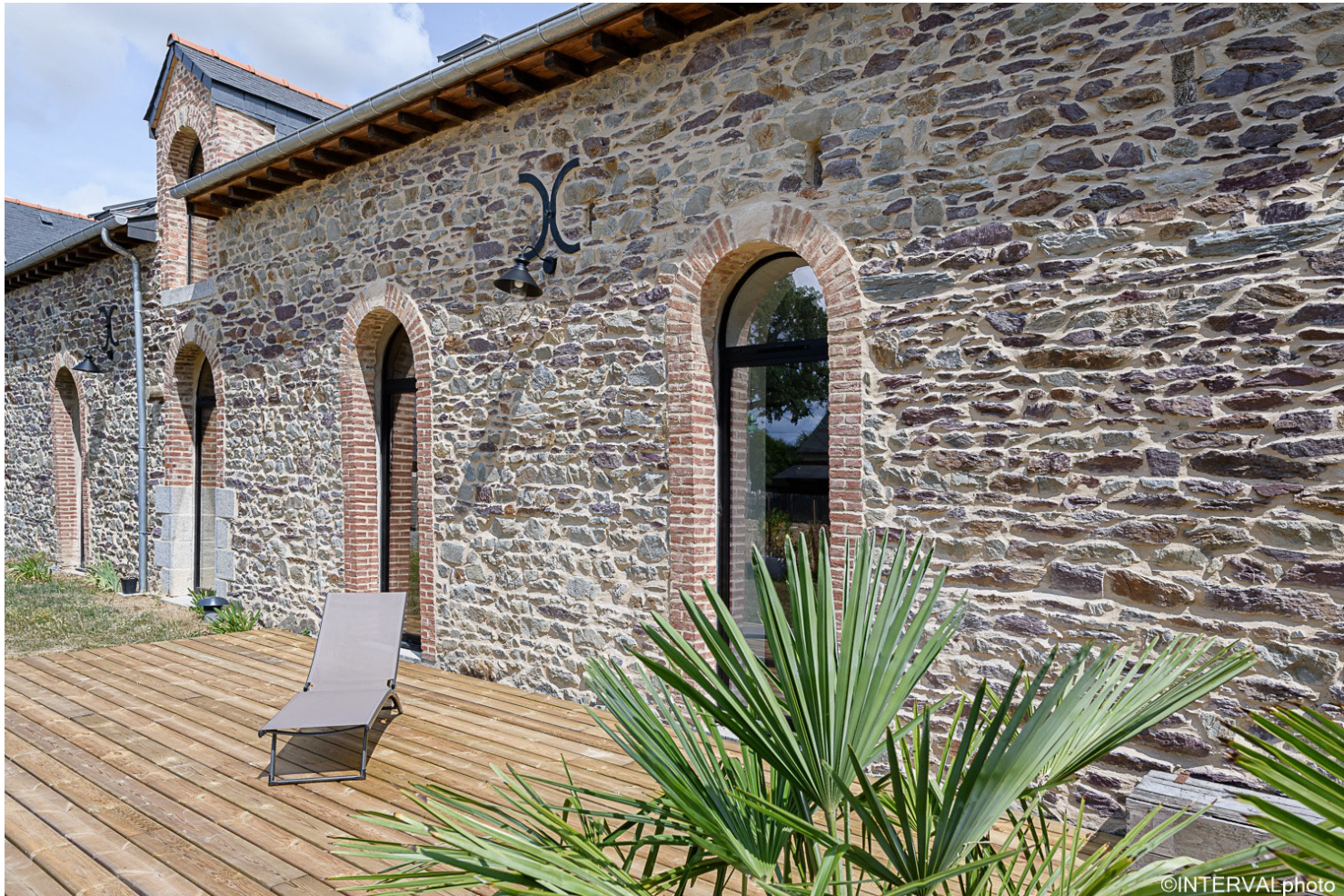
PHOTOGRAPHIE APRES TRAVAUX. FACADE SUD DE LA MAISON
