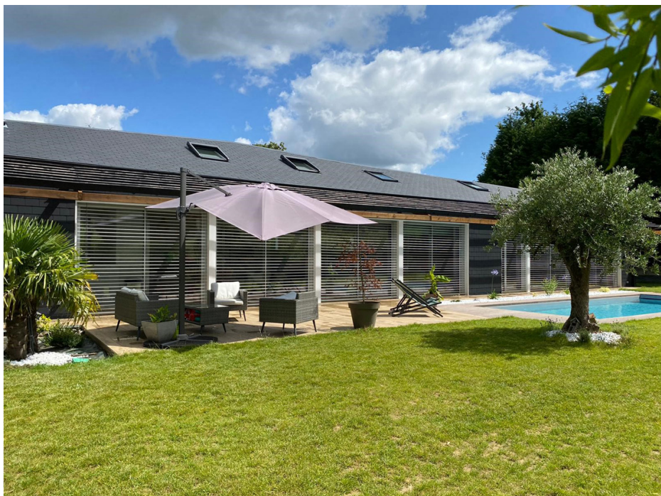
PHOTOGRAPHIES. LA FACADE SUD OUVERTE SUR LE JARDIN , ET PROTEGE PAR DES BRISES
