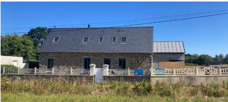
Sud- En cours
