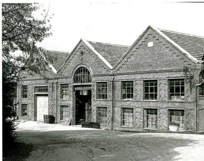
Le siège social de Aubaine Architecture est situé dans l'ancienne tuilerie de Montieramey
