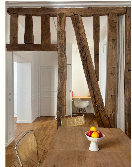
Photos avant / après de l'ouverture du mur souche et du traitement du mur à pan de bois
