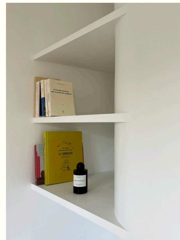
Ci-contre: Étagères en médium peint suivant l'arrondi de la cage d'escalier
