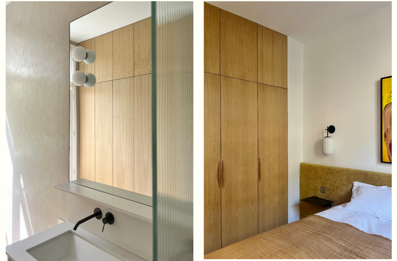
À gauche: La salle d'eau avec murs en béton ciré Marius Aurenti, miroir encastré, plan vasque en corian, pare-douche en verre flûte feuilleté
