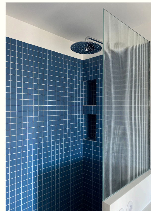
À gauche: Verrière en chêne et verre flûte réalisée en collaboration avec Assemblage Atelier, sol en linoléum naturel et carrelage 10x10cm CE.SIL À droite: La salle d'eau, habillage de la douche carrelage 5x5cm CE.SI et pare-douche sur-mesure en verre flûte feuilleté
