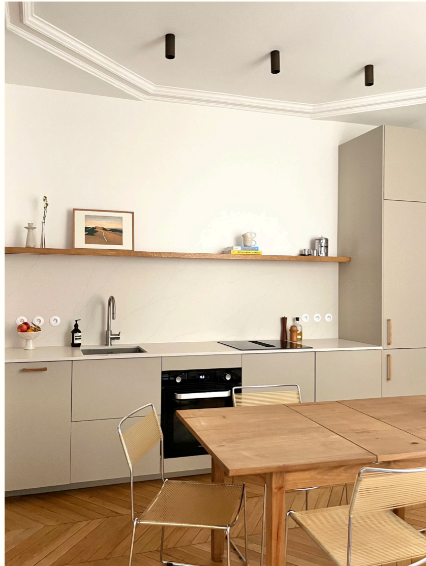
La cuisine: parquet ancien posé sur chape acoustique, façades IKEA, plan de travail en pierre recyclée, étagère en chêne huilé avec fixations invisibles
