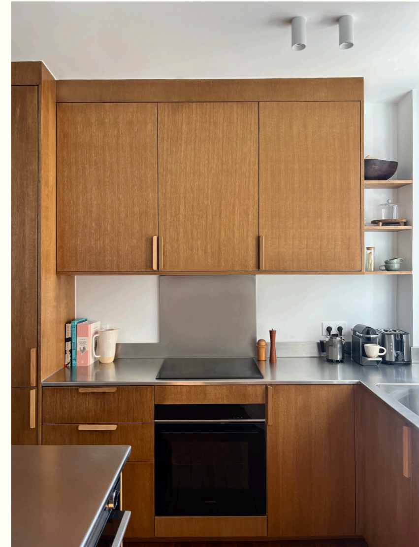
La cuisine: Plan de travailnet crédence sur-mesure en inox vibré y compris évier soudé, façades et étagères en placage chêne vernis
