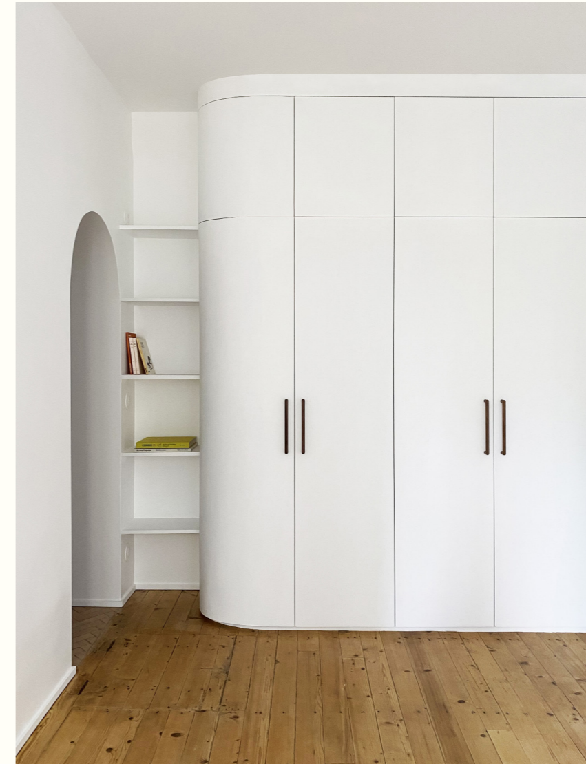
La chambre: plancher existant rénové, placard sur-mesure en médium cintré
