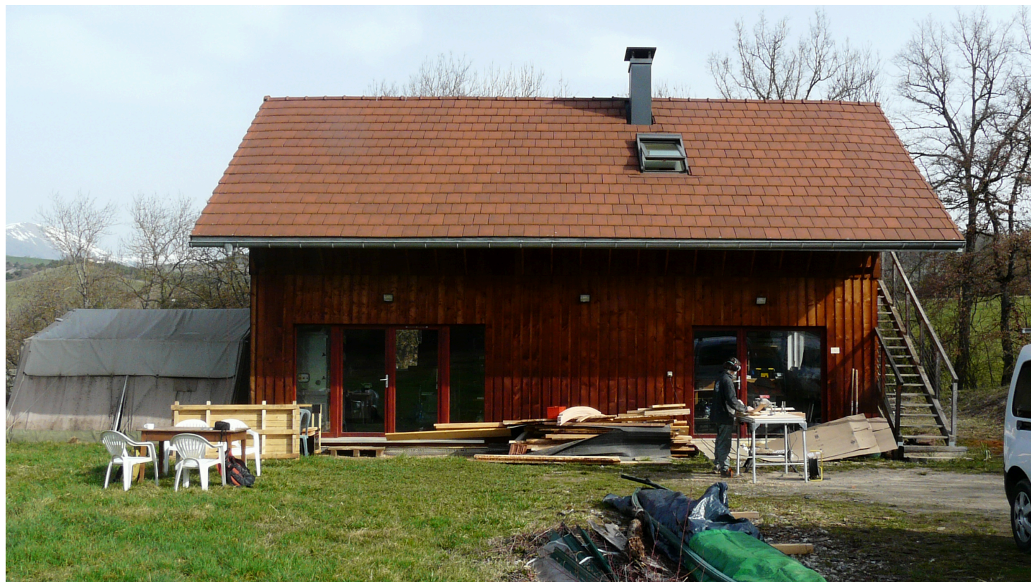
Façade sud de l'atelier existant - Crédit photo : EB
