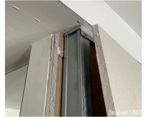
Détail rail / BAI3
