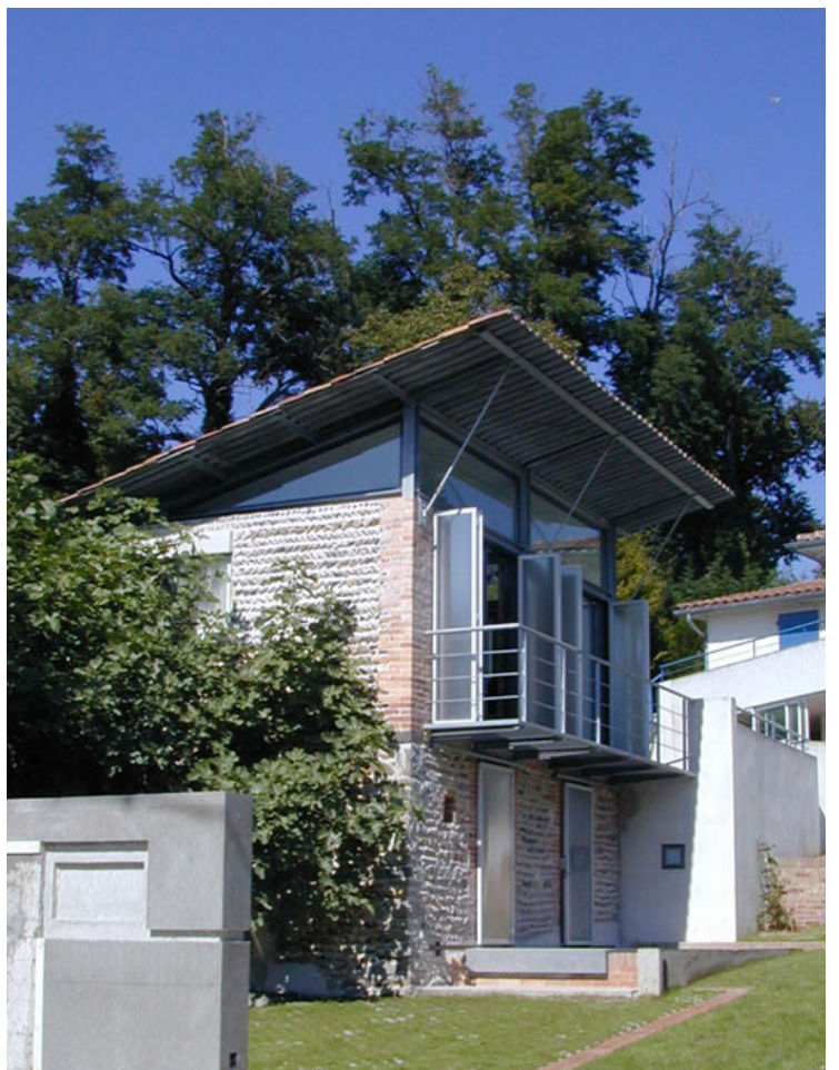
Transformation d'un séchoir en pièce de vie Prix départemental valeur d'exemple - mentionné
