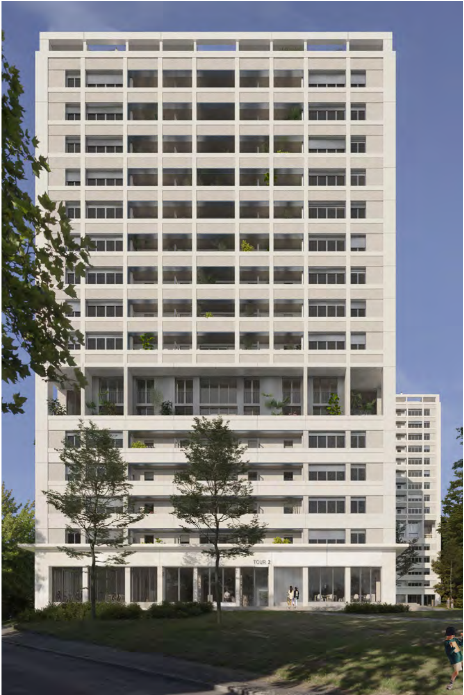
@Artefactorylab - Perspective du projet - vue sur la tour 2, la tour 4 en arrière plan.
