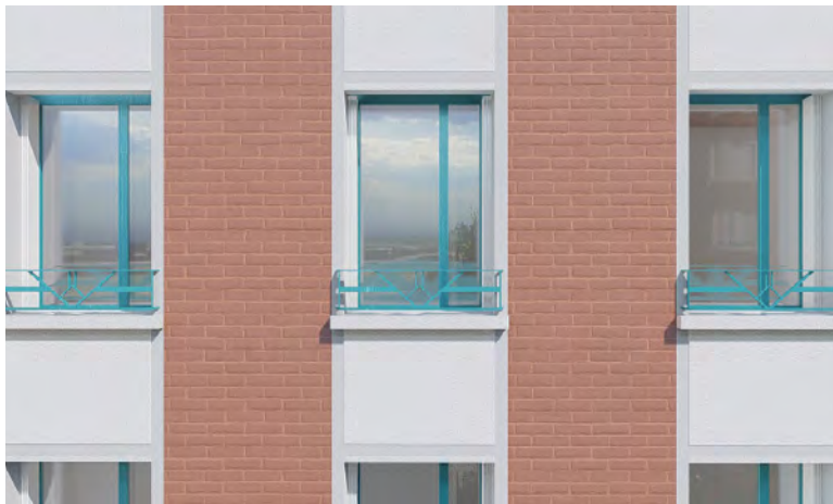
Image du projet - Travée de type menuiserie sur allège avec serrurerie art déco - Interventions sur les menuiseries
