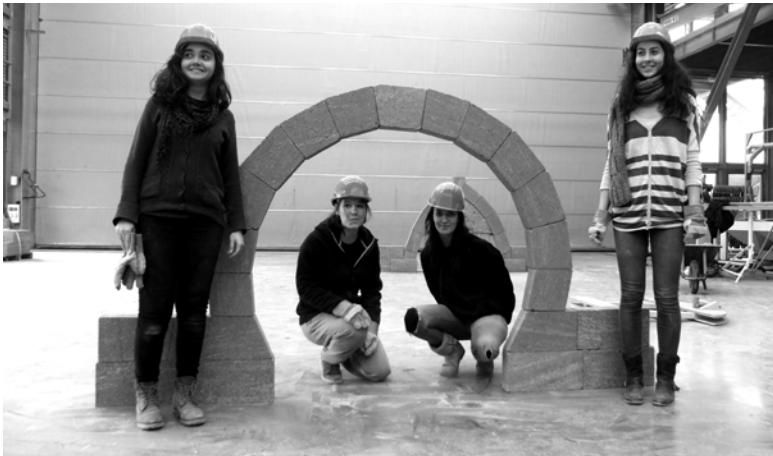
Réalisation de 4 arcs clavés : brisé, outrepassé, platebande et surbaissé L'épure est dressée au sol puis les claveaux sont taillés à la main avec gouges, scie crocodile, ciseaux et chemin de fer, le coffrage est réalisé, l'arc est assemblé avant le décoffrage. Puis les arcs sont chargés pour observer leurs résistance mécanique.
