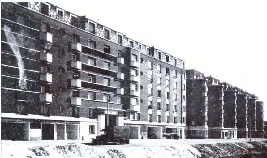
Photographie de la rue Claude Monet - photo non datée. Le premier bâtiment est en fin de chantier. Les travaux de fondation du deuxième sont en cours au premier plan. Au regard de l'arrêté du permis modificatif, il pourrait s'agir d'une photographie de 1939.
