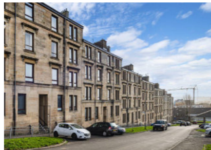
04_SI_TENEMENTS, IMMEUBLES COLLECTIFS_5
