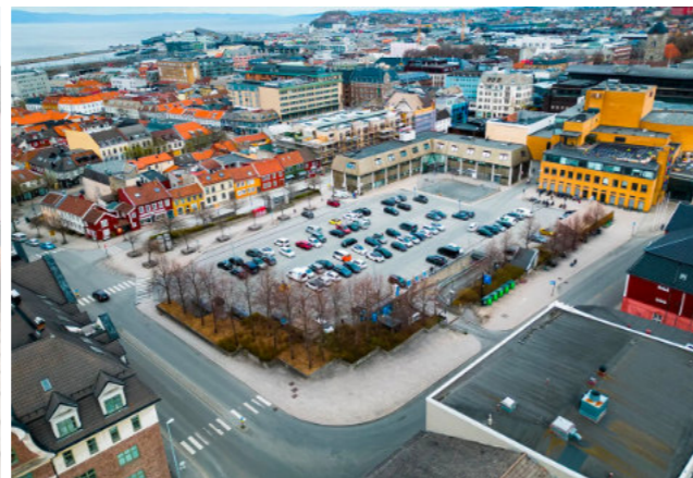
15_SI_VUE AERIENNE DU SITE_2
