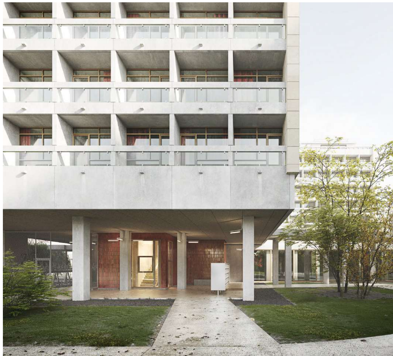
Les pilotis libèrent des rez-de-chaussée généreux
