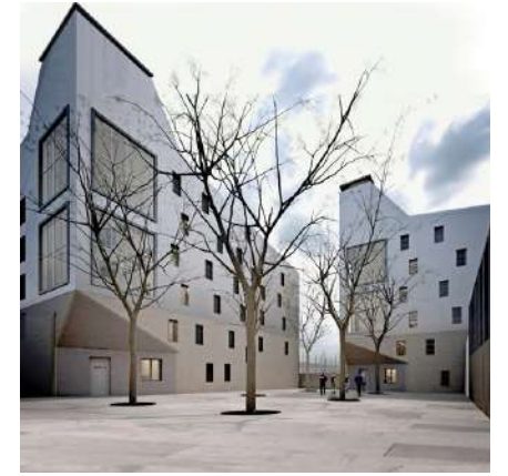
Aix-Luynes II - Maison d'arrêt
