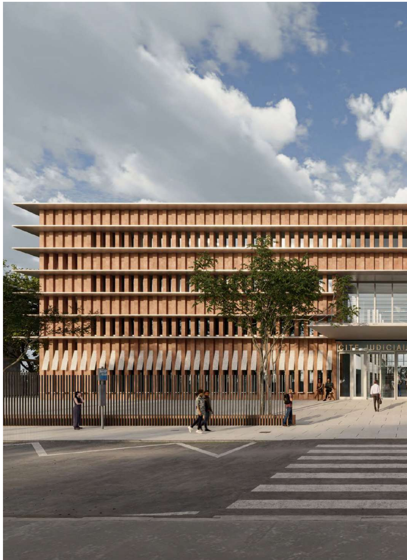
La façade principale en béton teinté à la latérite, une terre locale
