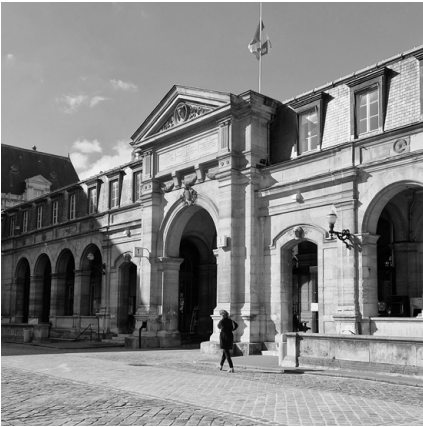
Paris - Réhabilitation amphithéâtres
