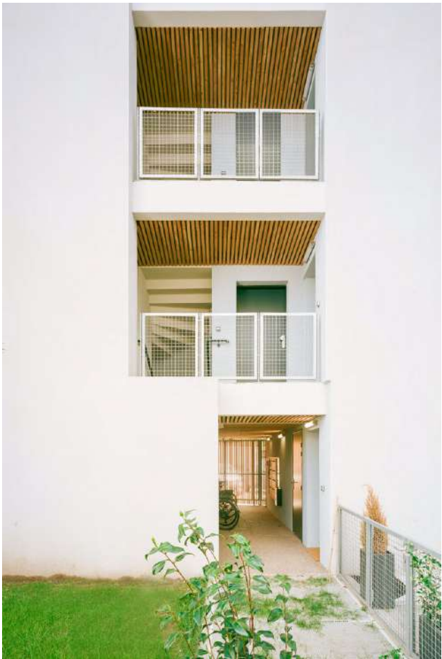
Le hall traversant sur jardin
