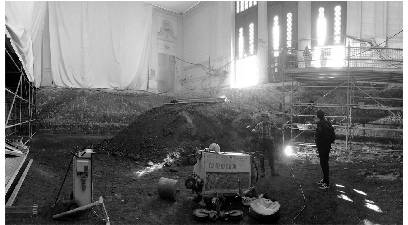
La salle des pas perdus en chantier
