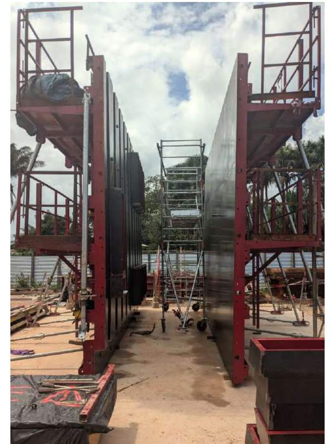
Les banches sur mesure importées de métropole
