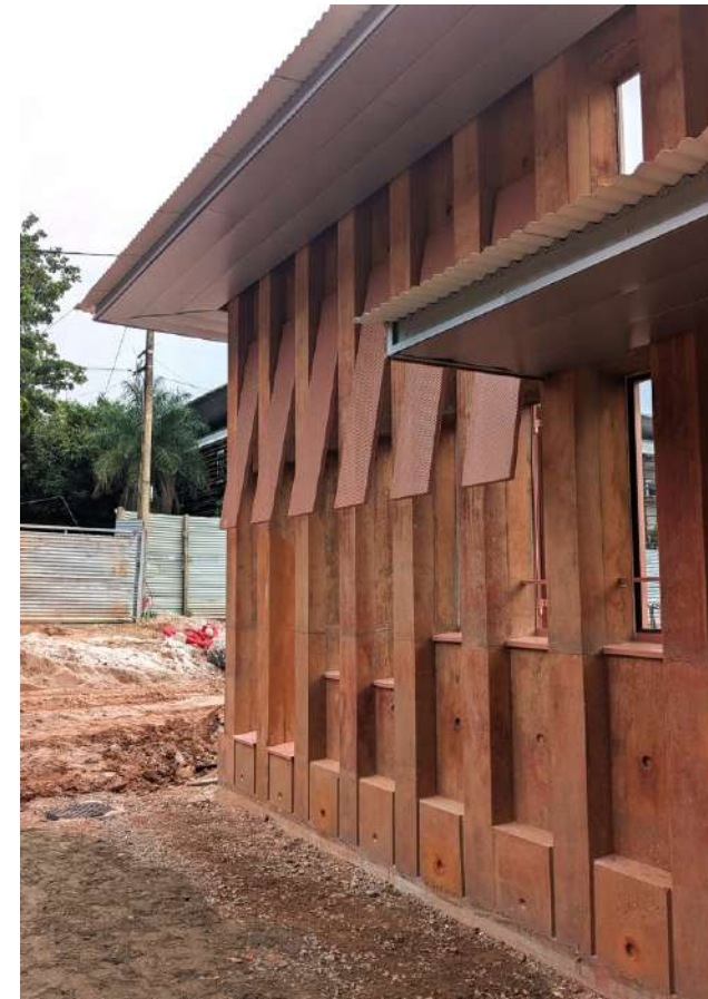
prototypage de la façade principale en béton banché
