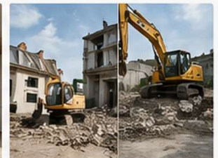
DÉCONSTRUCTION SÉLECTIVE Tri, recyclage & valorisation
