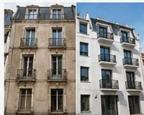
IMMEUBLE D'HABITATION Rénovation complète
