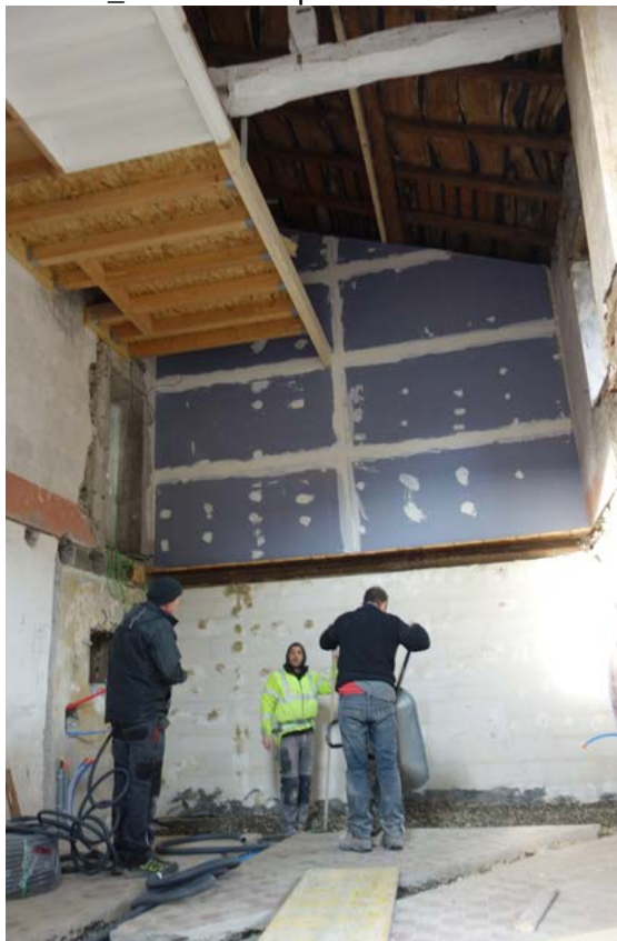
Aile Est _ réfection du plancher intermédiaire
