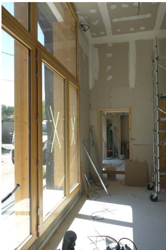
Aile centrale _ L'ouverture de 12m 2
