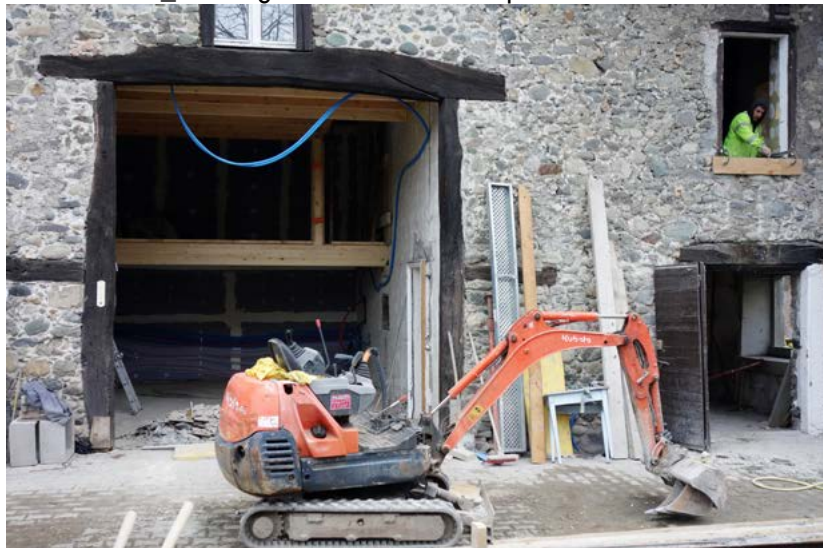
Aile centrale _ fin du gros oeuvre avant la pose des menuiseries
