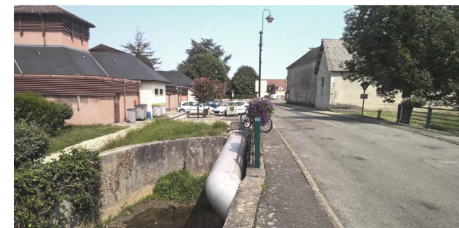
Vue de l'état existant.
