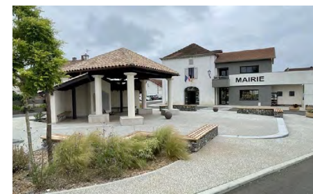
Travaux réalisés par la CCLO. © Bellocq
