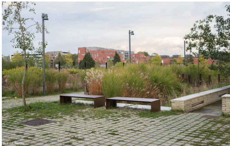
Pavés drainants enherbés.
