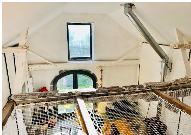
Filets dans le prolongement de la mezzanine.
