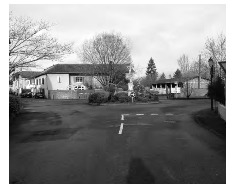
Etat avant travaux.
