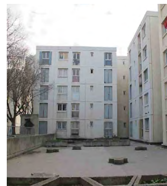
Vues des bâtiments existants.
