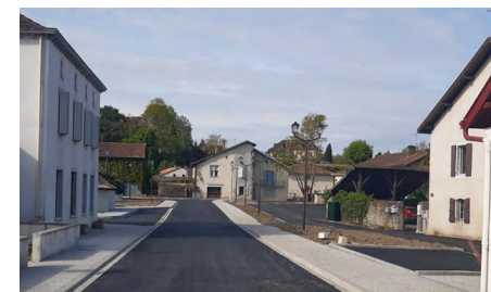
Travaux réalisés par la CCLO. © Bellocq
