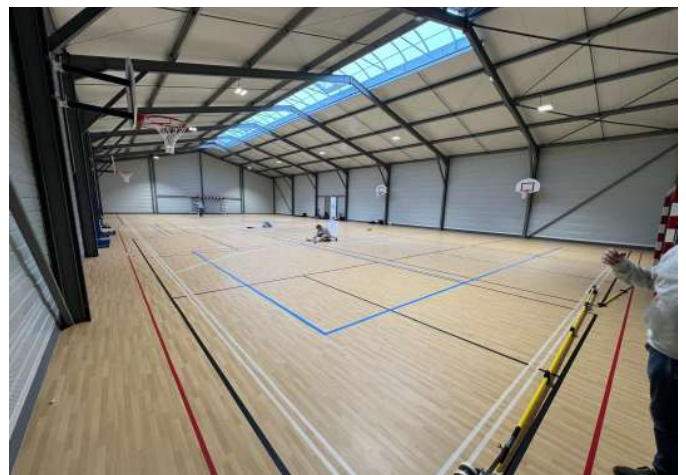
Gymnase terminé avec sol neuf, marquage et paniers de basket.
