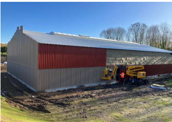
La couverture et le bardage existant ont été déposés et remplacés.
