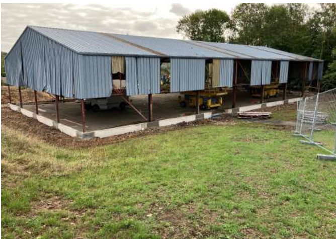
Gymnase existant, seule la structure métallique sera conservée.
