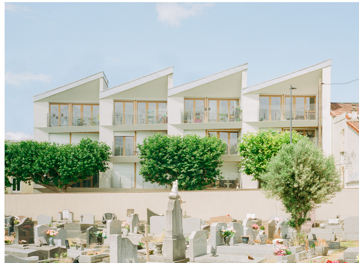
Les gardes-corps en caillebotis métalliques préservent les vues sur l'horizon
