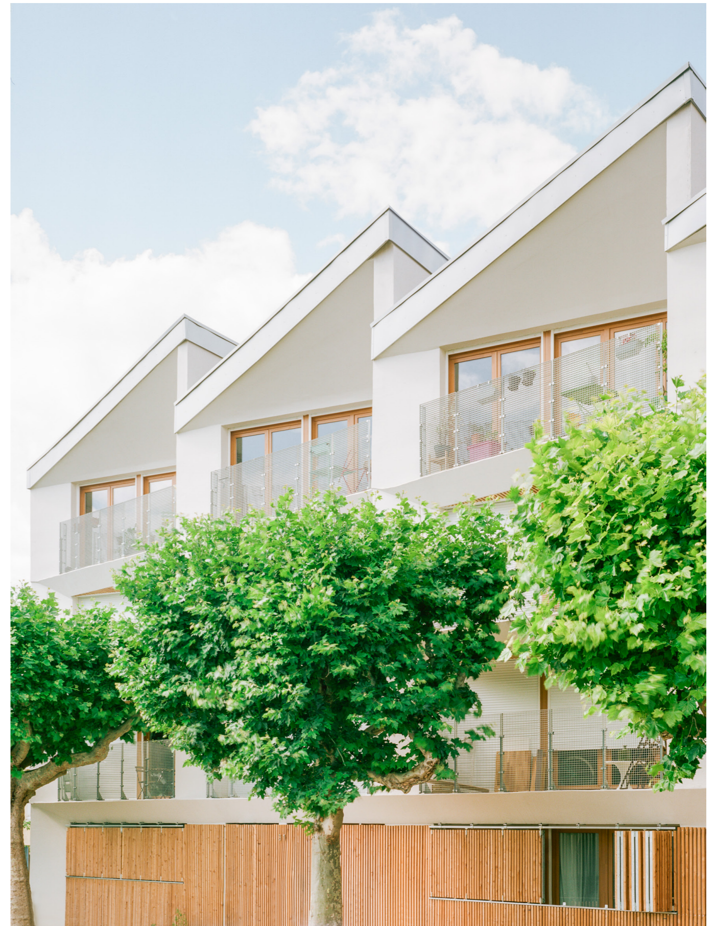
Au rez-de-chaussé, les terrasses sont protégées par des volets persiennes en bois
