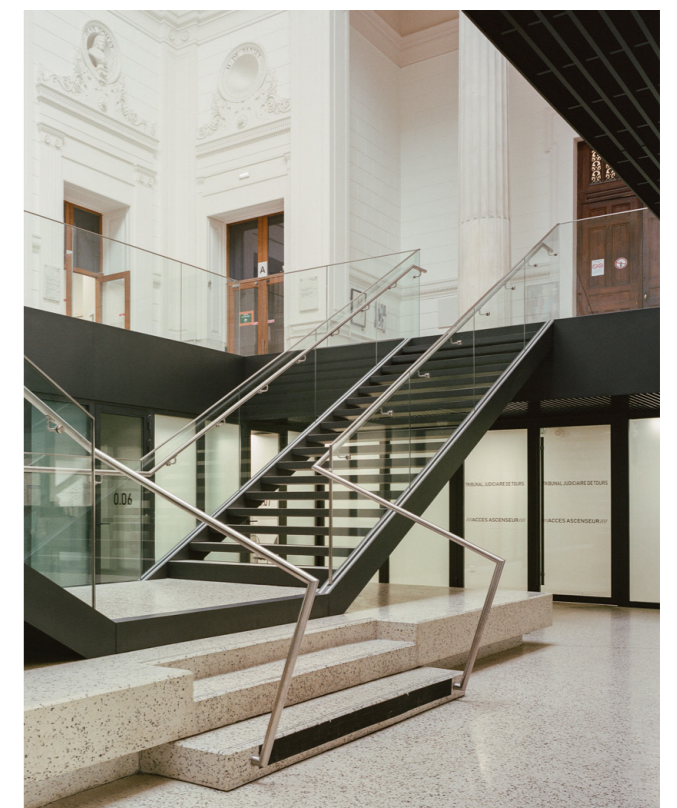
L'escalier en acier, pierre et verre
