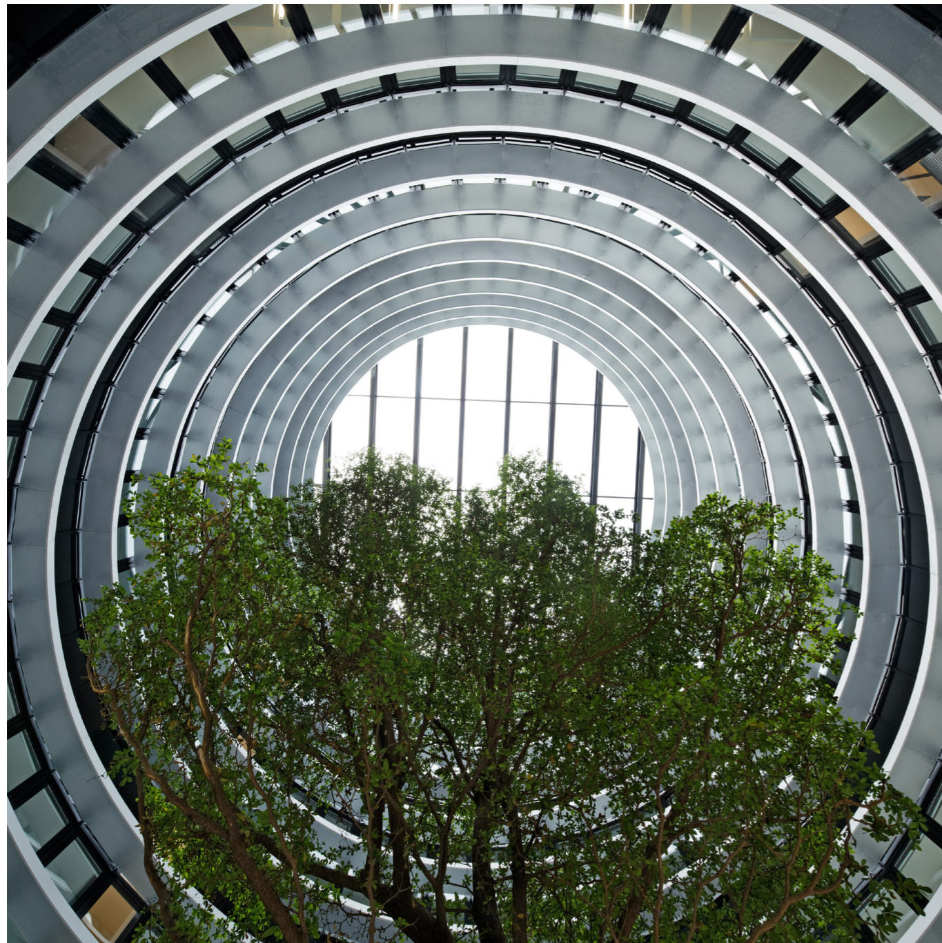
L'atrium central participe à la ventilation naturelle des espaces publics
