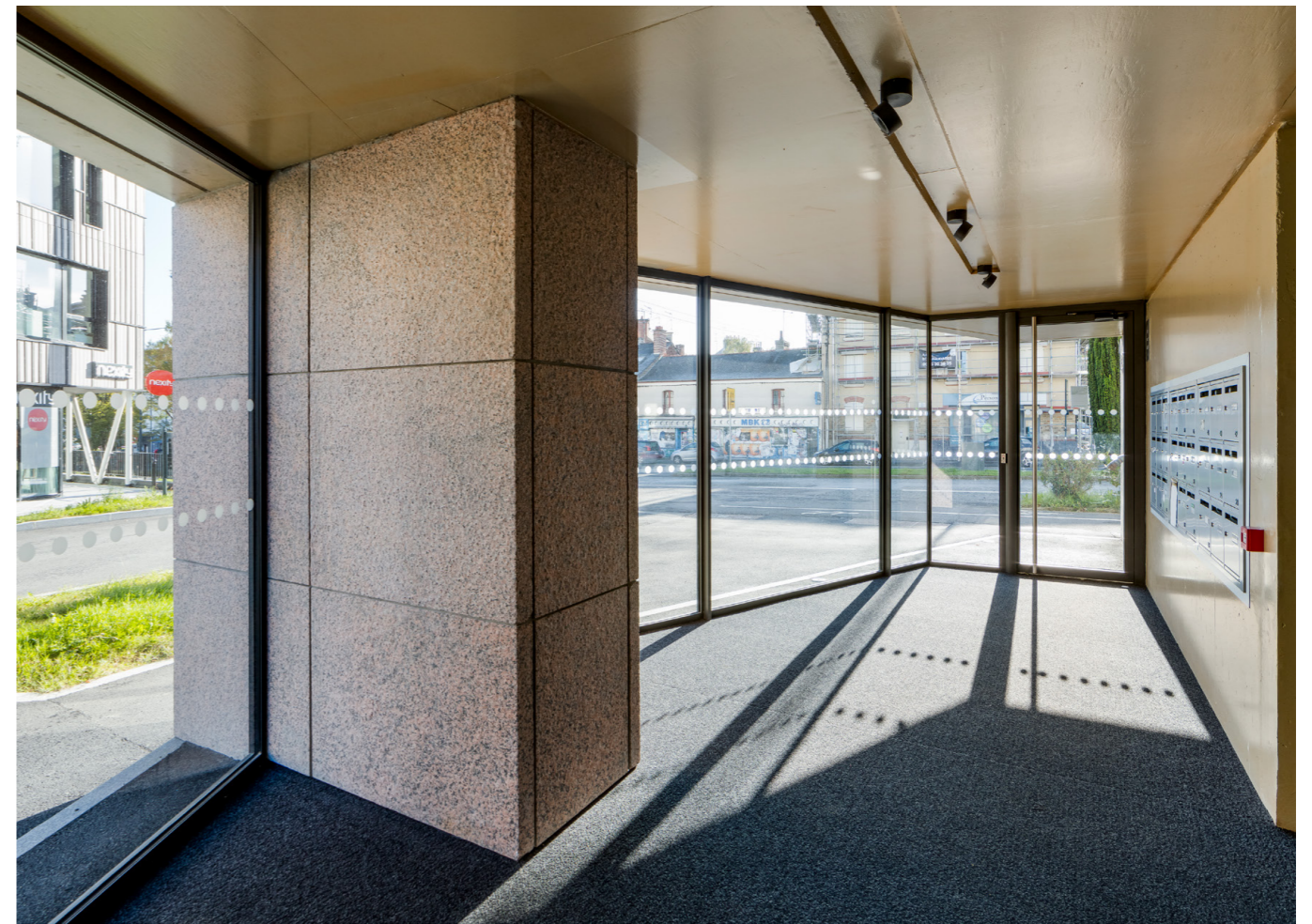
Des piles de granit rose des carrières de Perros-Guirec signalent chaque entrée
