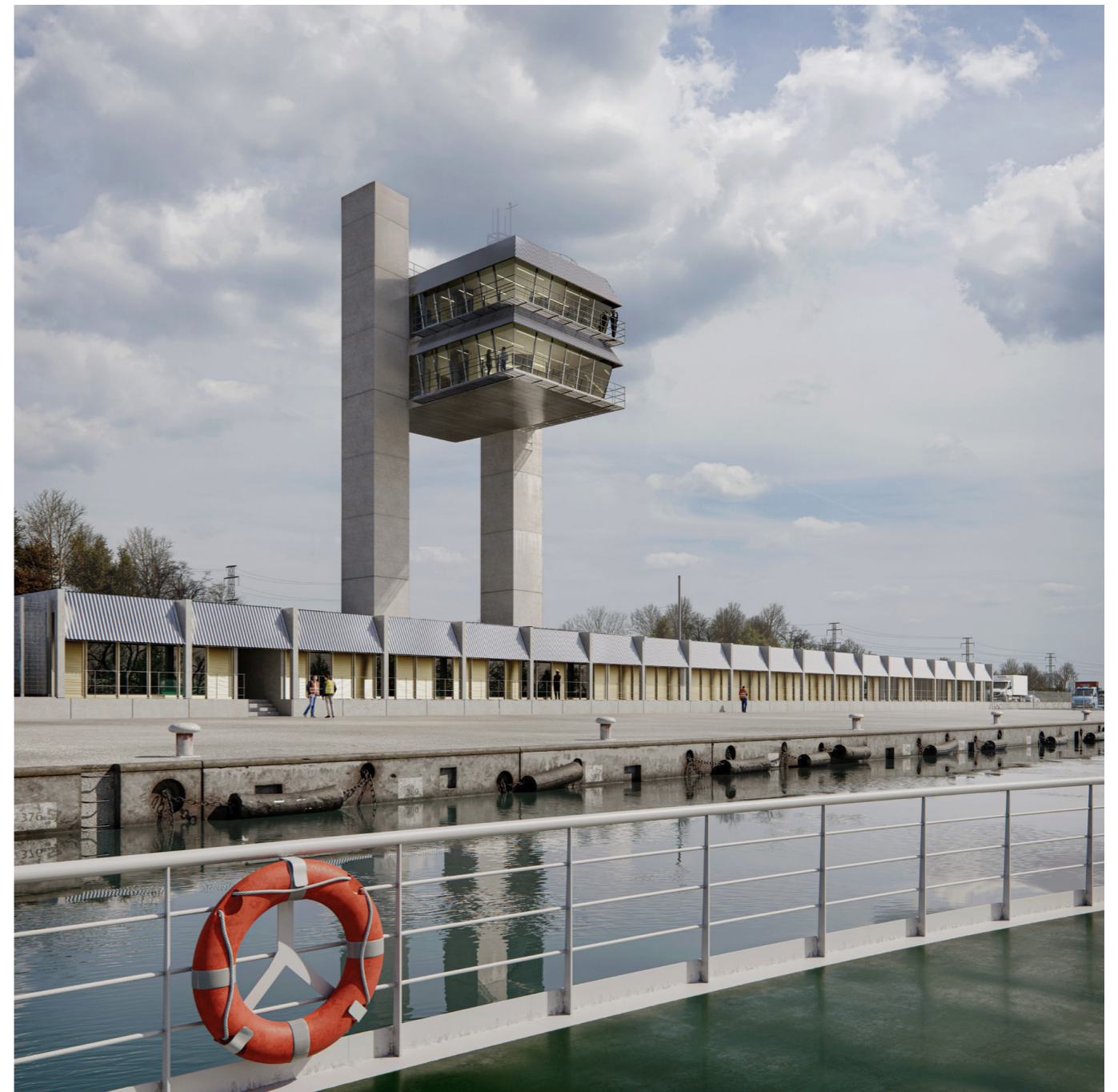
La vigie en porte à faux est sur deux piles très fines créant un effet élancement
