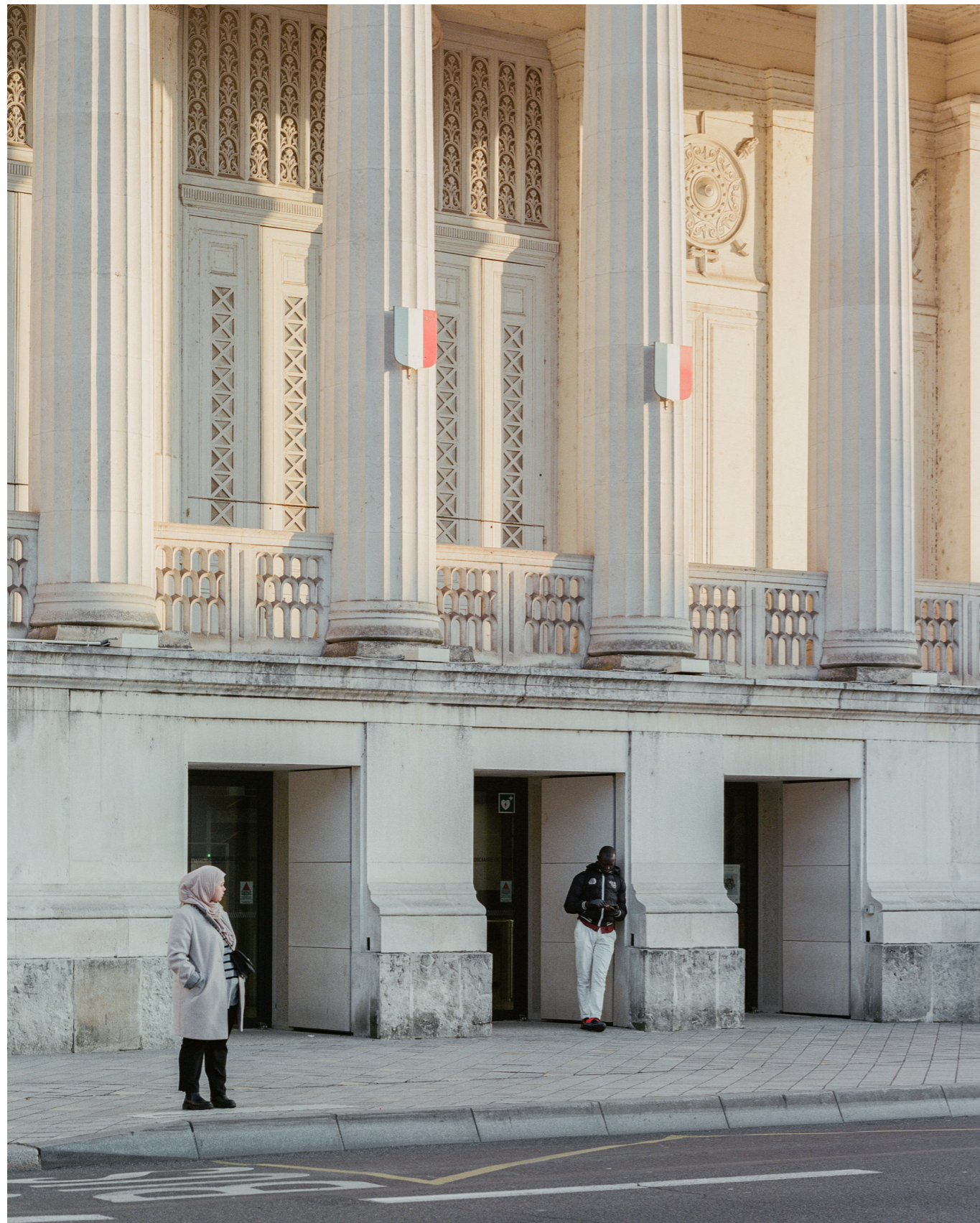
Le socle du péristyle ouvert pour créer un nouvel accès de plain-pied sur la chaussée
