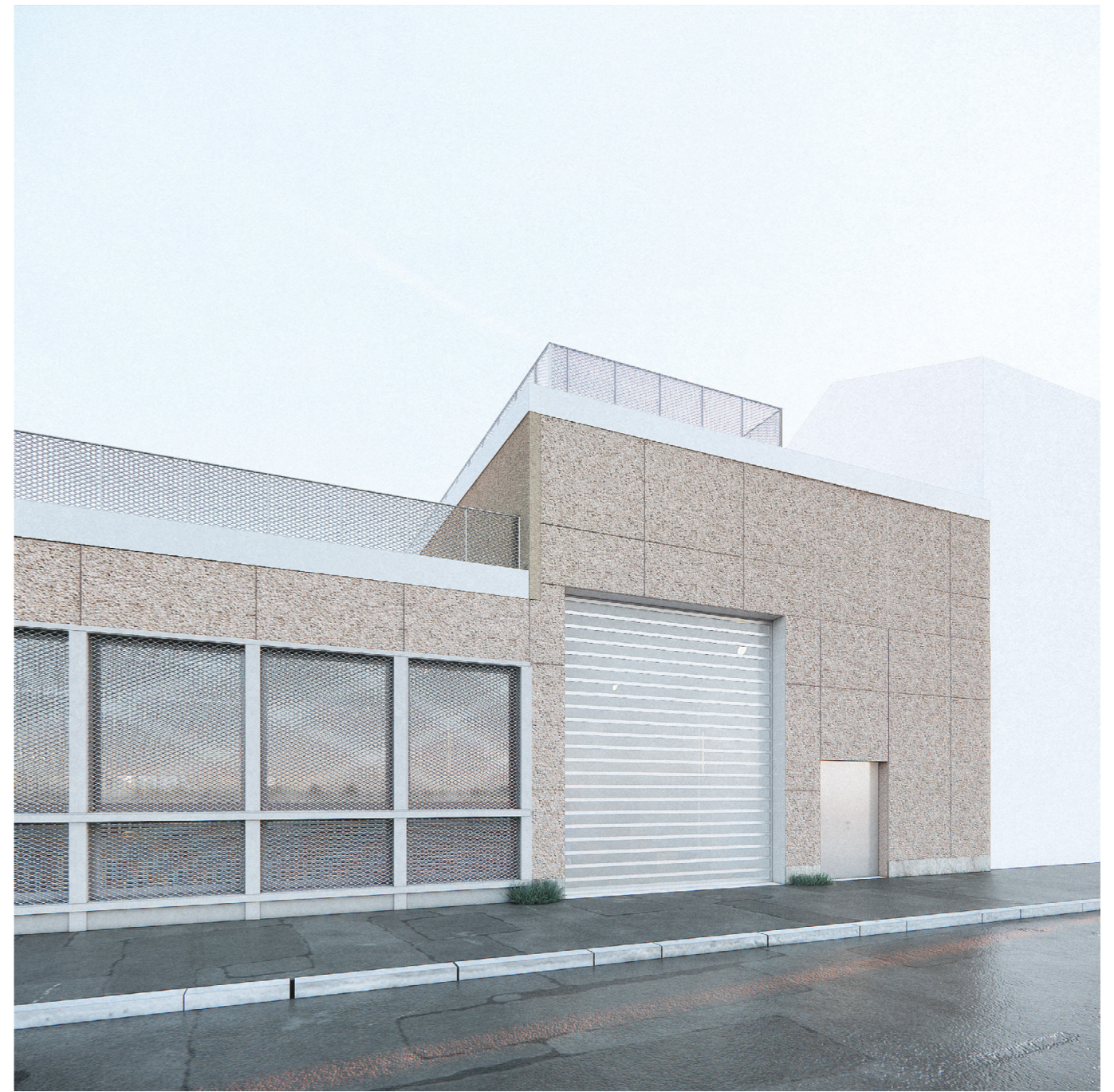
La grande porte d'atelier existante est conservé et un garde-corps métallique bareauté est installé en toiture
