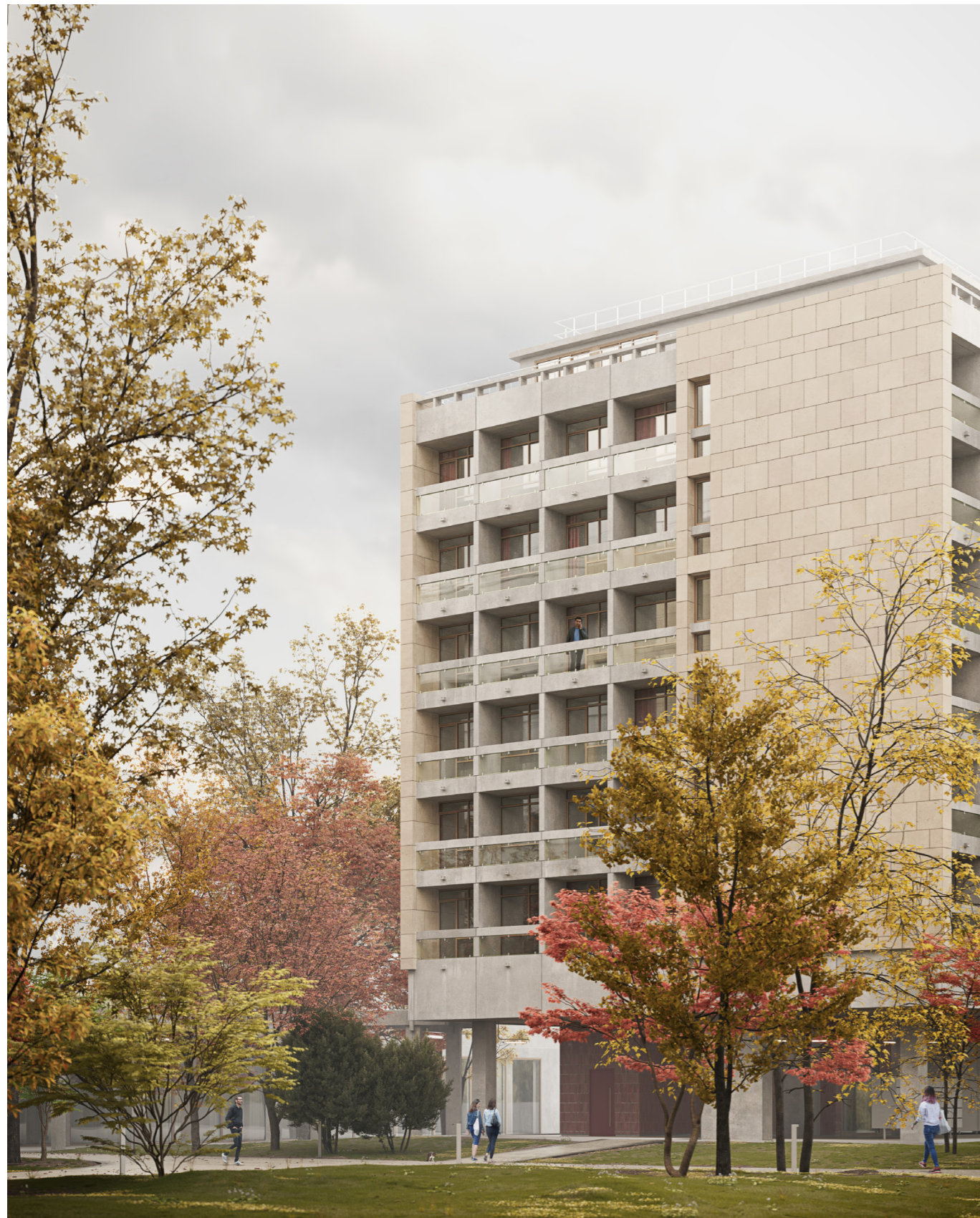
Les pignons en pierre sont refaits à neuf
