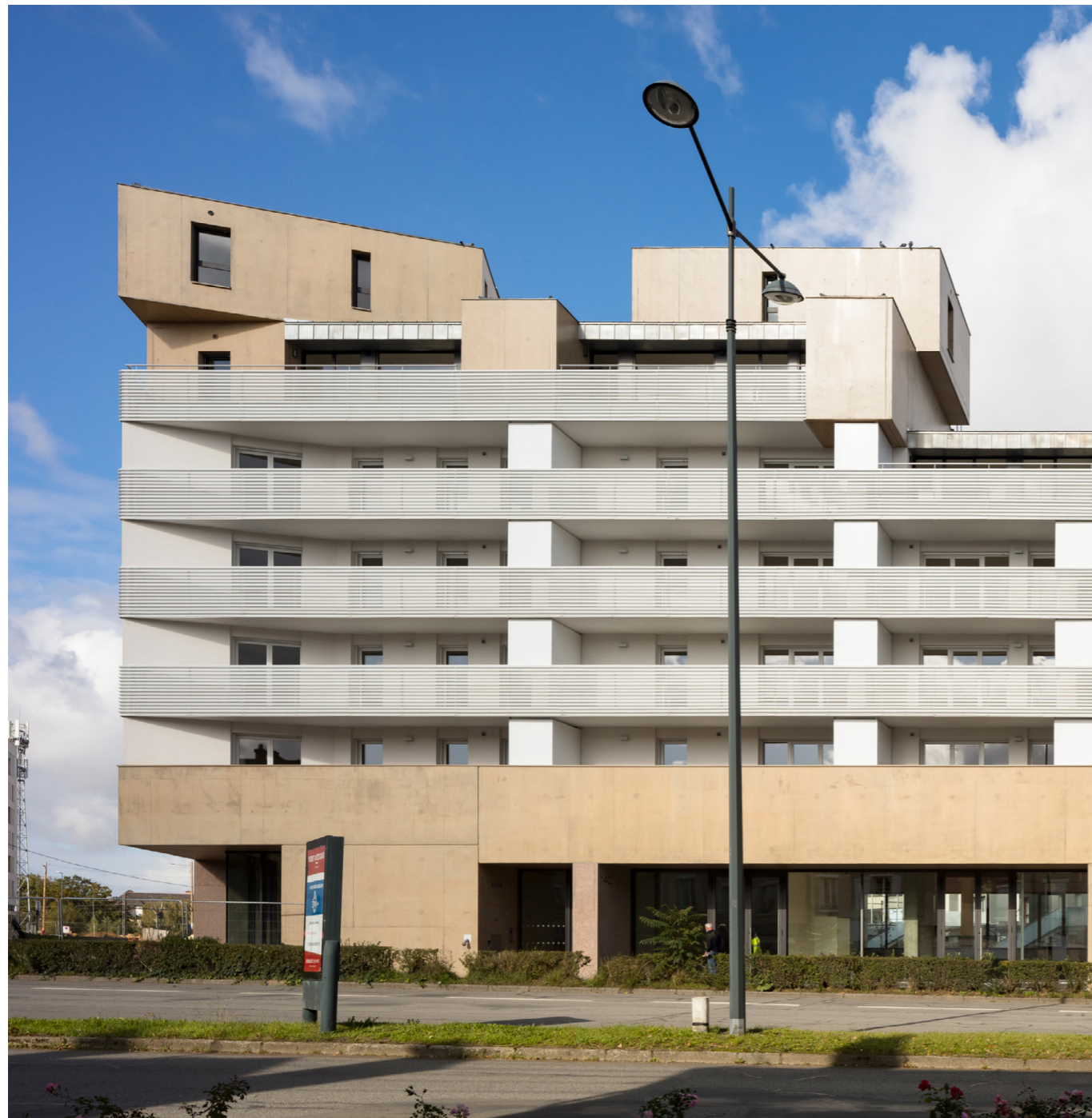
L'empilement cyclopéen de blocs de béton accompagne la déclivité du terrain
