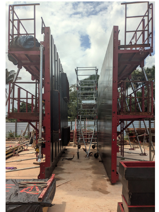
Les banches sur mesure importées de métropole
