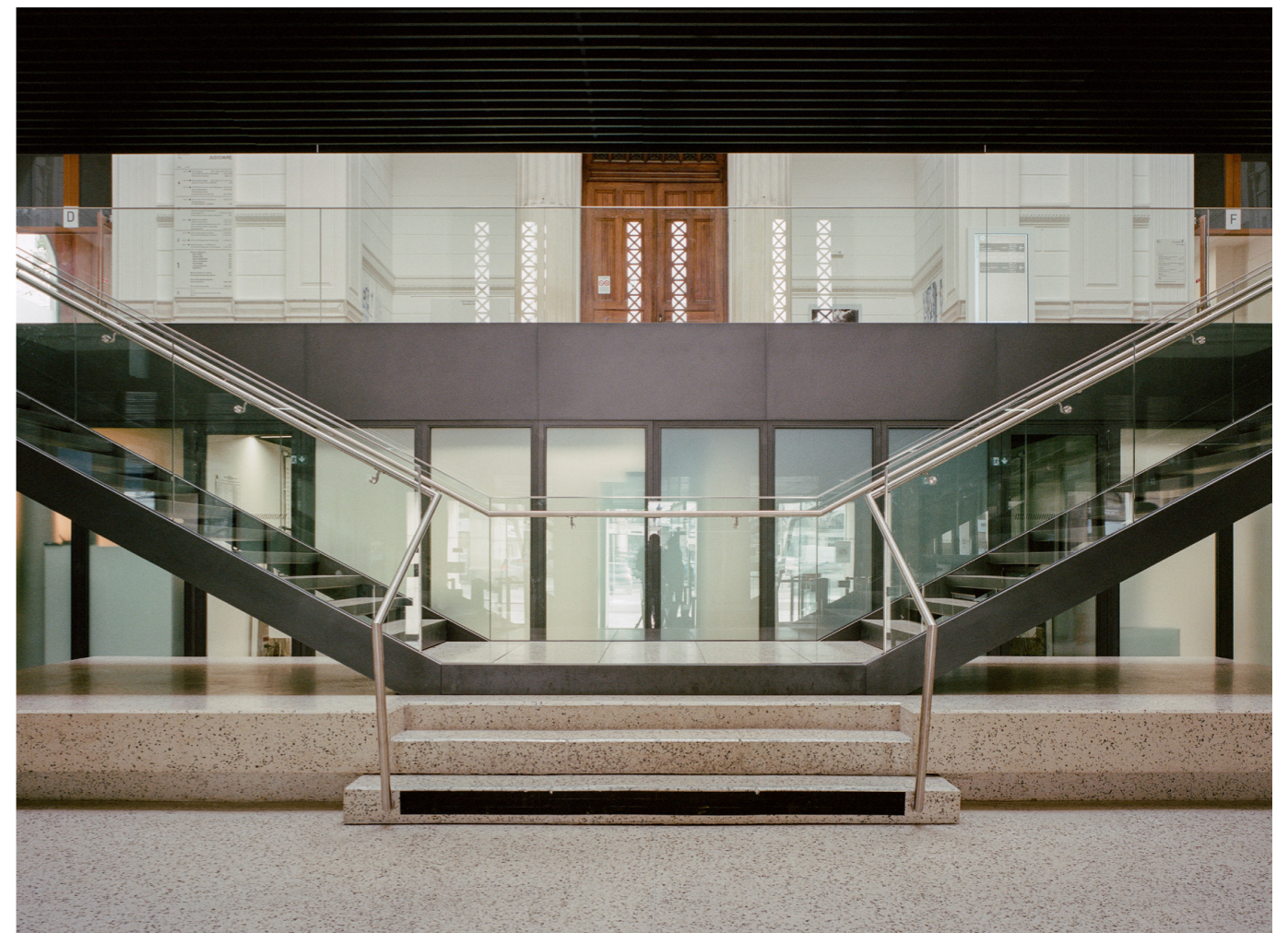
Escalier monumental en cœur de projet : geste architectural structurant et lisible dès l'entrée
