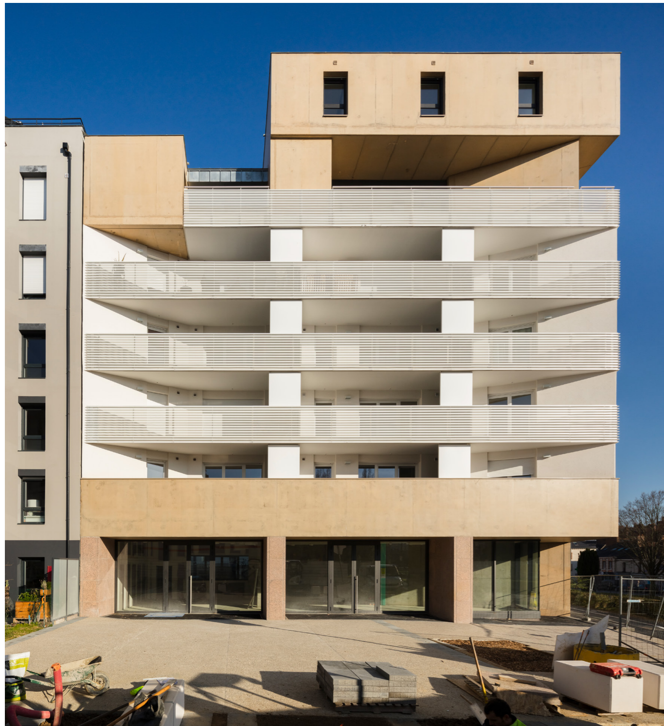
De larges loggias protégées par des garde-corps en tôle nervurée perforée
