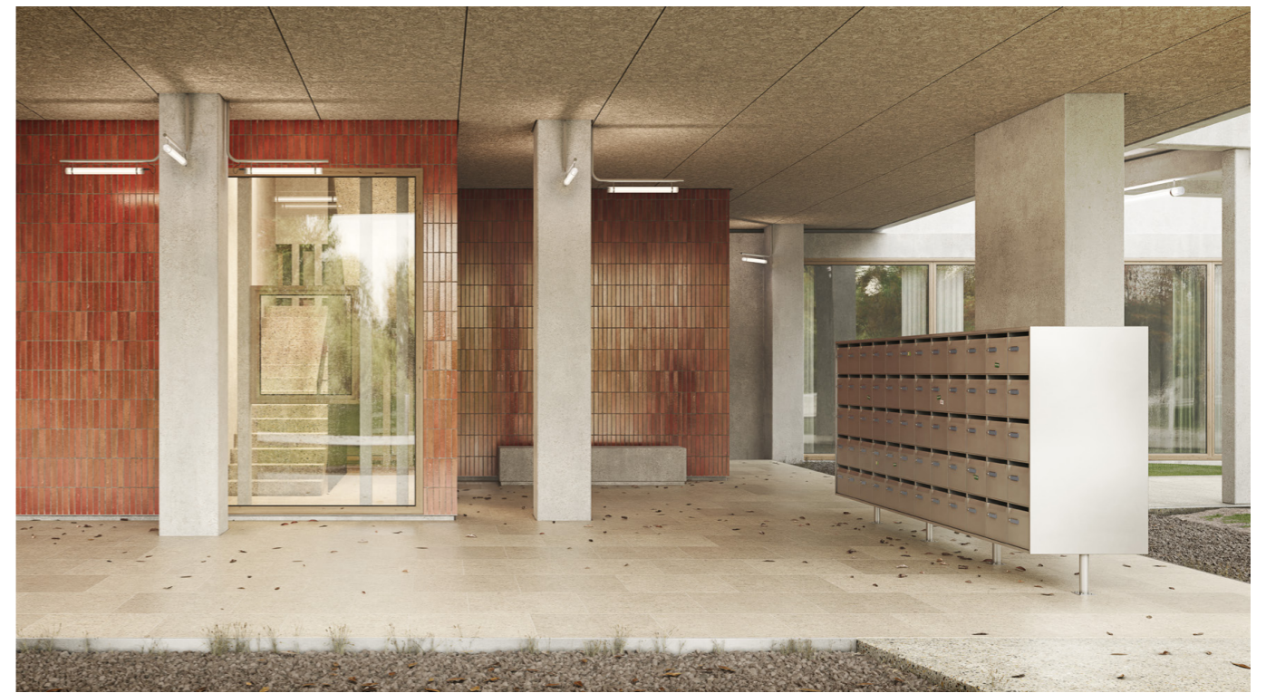
Le dallage en pierre est issu du réemploi de l'ancien bardage de façade
