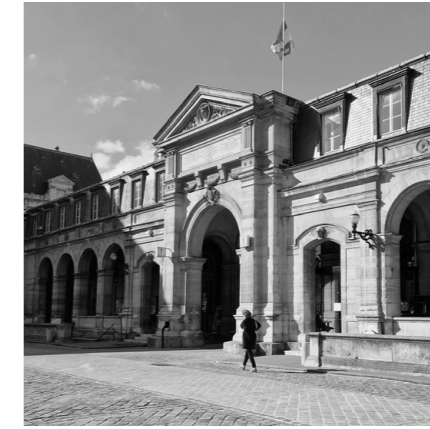
Paris - Réhabilitation amphithéâtres
