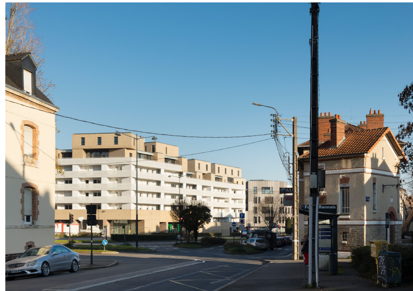
Le bâtiment reprend les matériaux et teintes du Foyer Rennais, résidence sociale des années 1930
