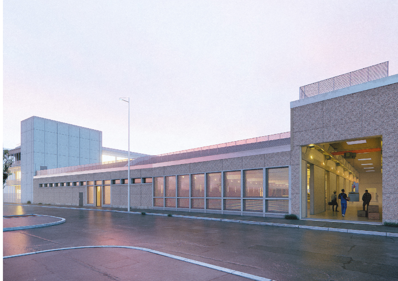
La façade sud donnant sur la rue de l'Abbé Lemire
