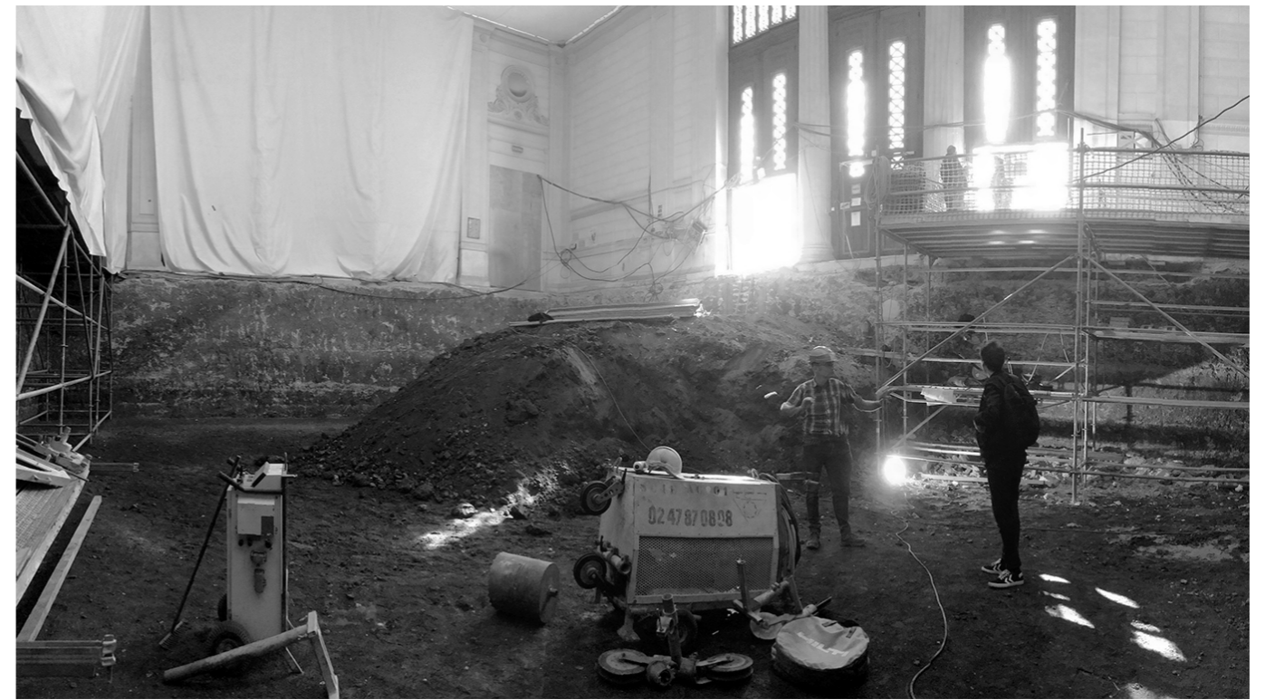
La salle des pas perdus en chantier
