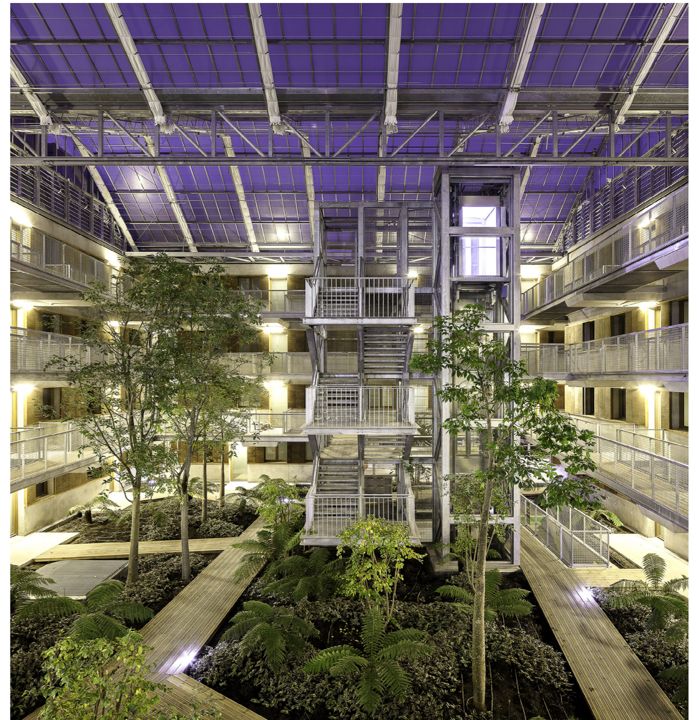
Les serres, issues du monde horticole, sont gérées par un automate et équipées de stores d'occultation
