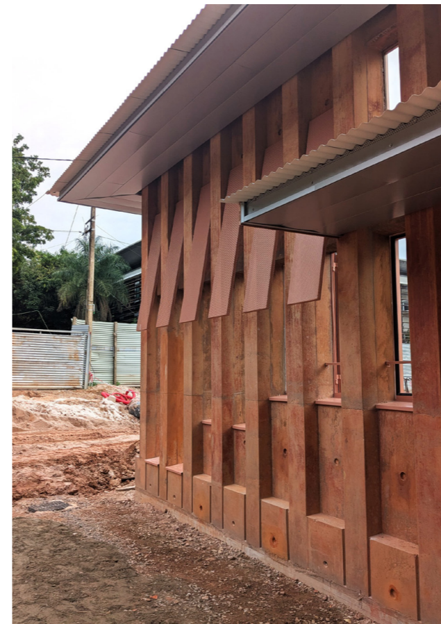
prototype de la facade principale en béton banché
