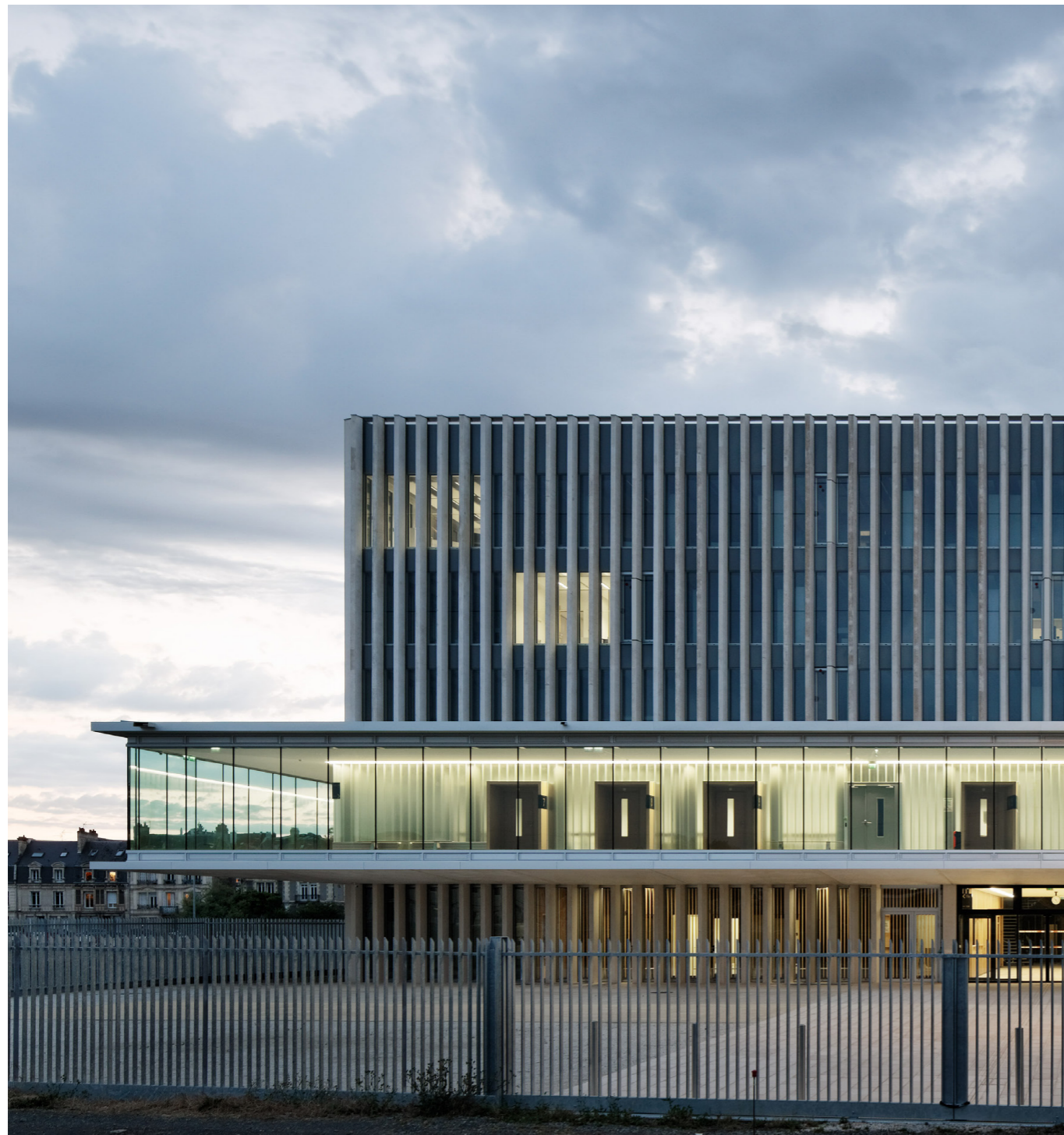
Les fines colonnes de béton blanc préfabriqué sont structurelles et d'un seul tenant
