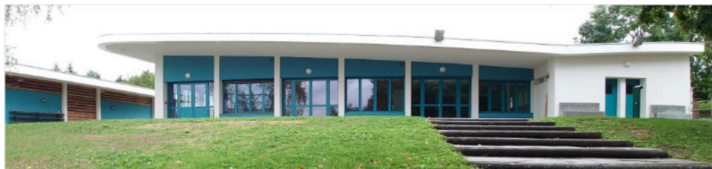
Isolation thermique par l'extérieur
