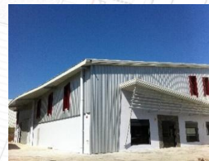
« Entrepôt I.M ZADVAT » 2014 Espace Vente/stockage – La Mare
