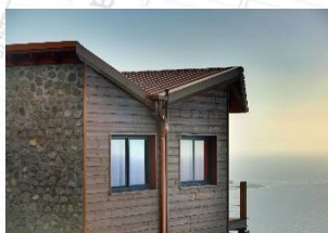
Villa « ANFOSSO » - 2011- en bois et moellons - La Possession
