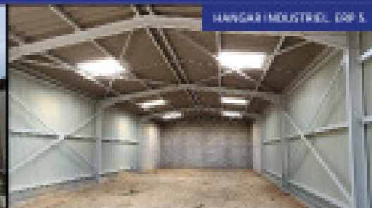
HANGAR INDUSTRIEL. CDP 5.
