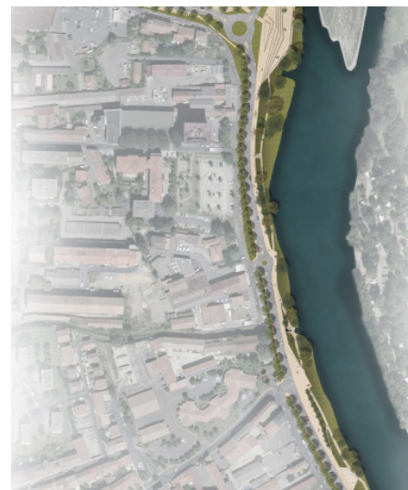
AMÉNAGEMENT DES BERGES DU TARN
