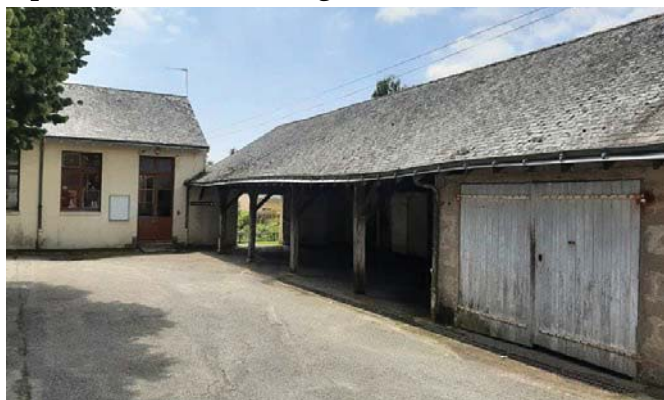
Façade Cour de la Poterie, avec pieds de poteaux rongés et charpente affaissée
