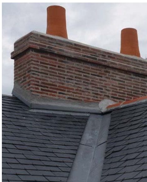
Réfection de couverture ardoise et souche de cheminée
