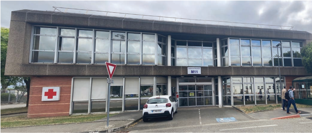
Photo de l'existant
