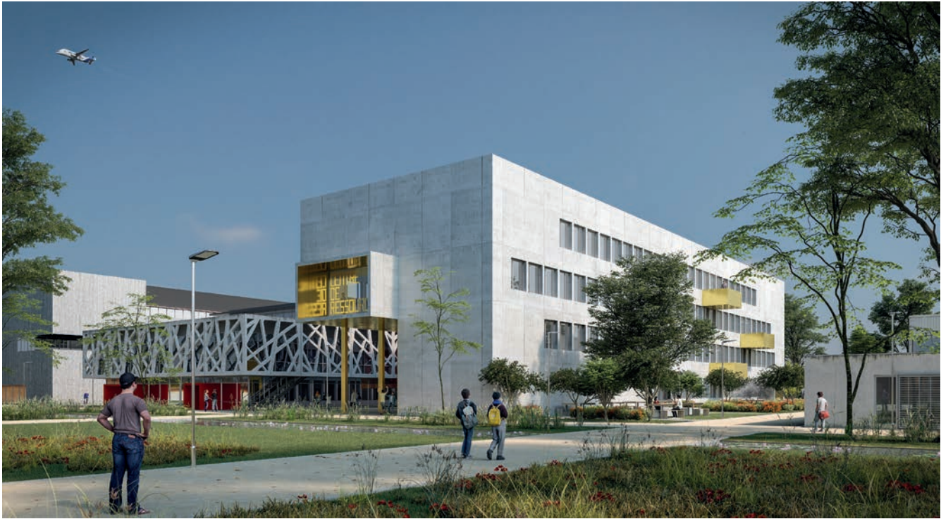
Perspective sur l'aménagement paysagé depuis coulée verte
