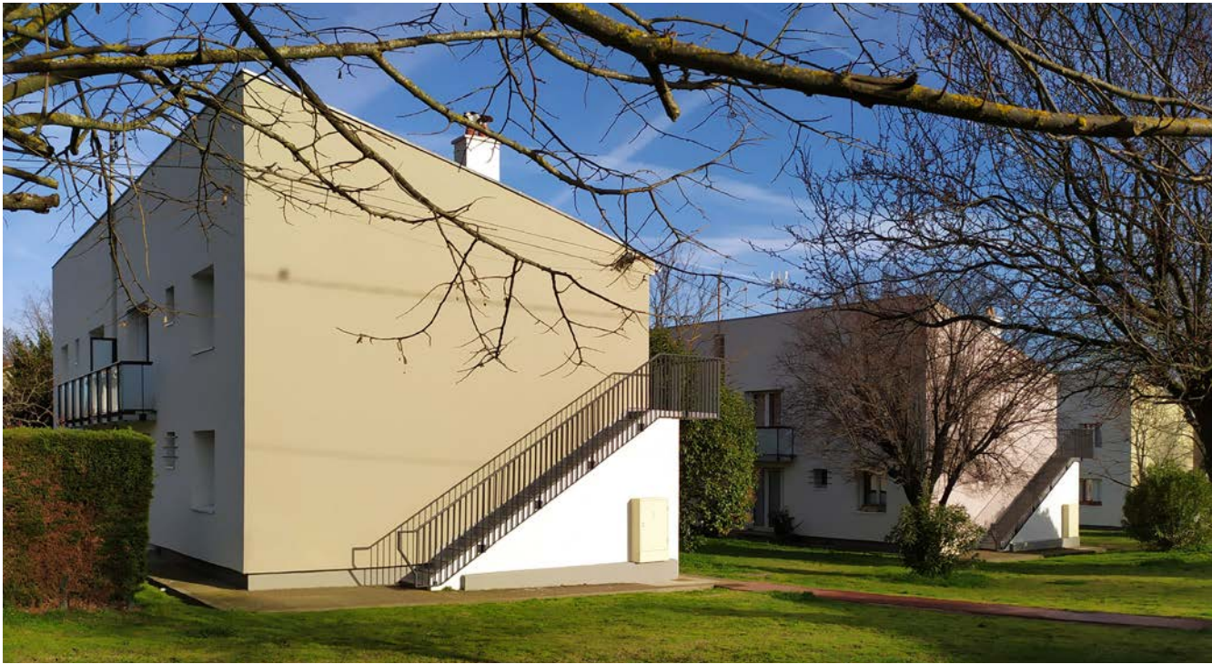
Photographie sur façades latérales
