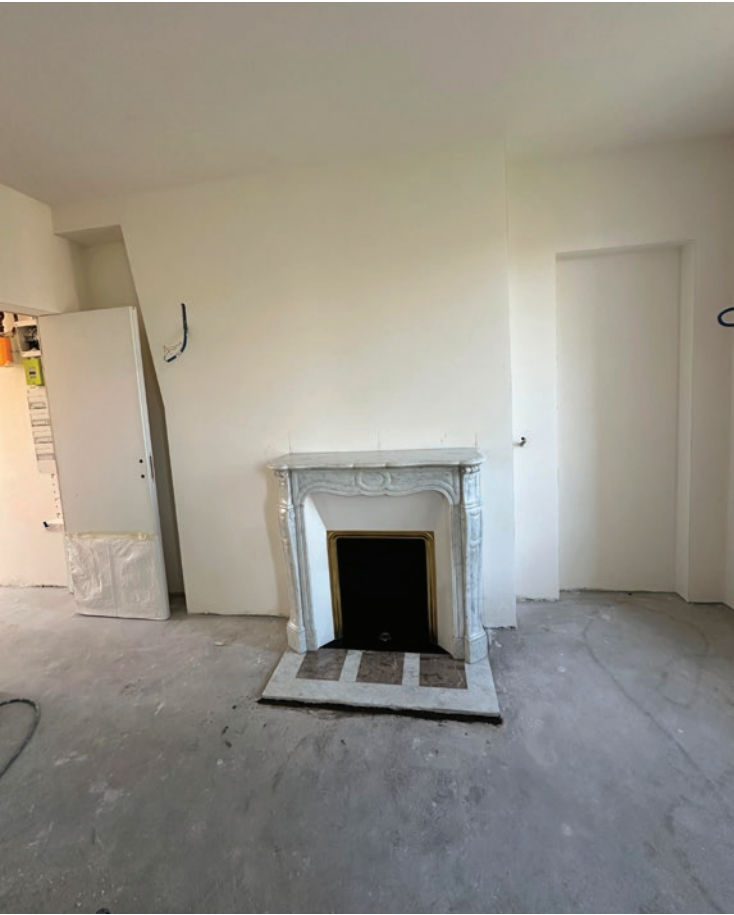
Création d'une cheminée
