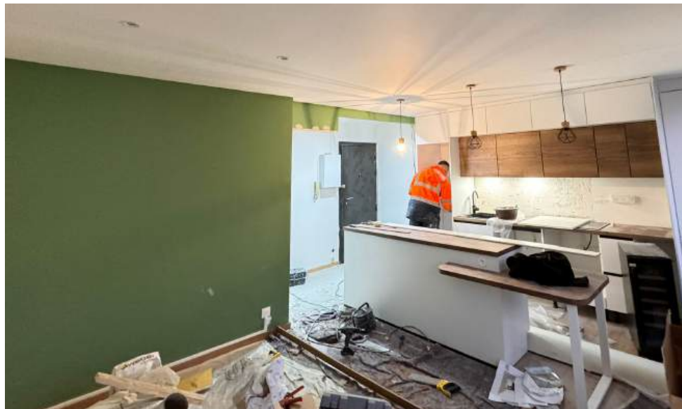
Cuisine et Salle à Manger/Chantier
