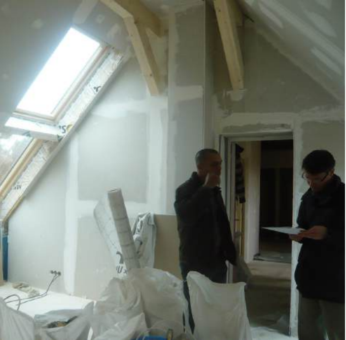
Chantier Intérieur Extension
