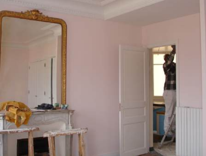
Salle à Manger/Chantier
