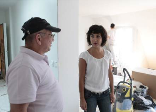
Salle à Manger/Chantier
