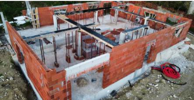
Cuisine et Patio Intérieur/Chantier
