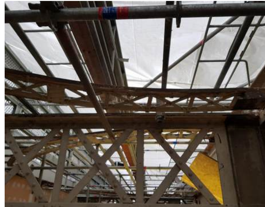
Détail Structure Eiffel
