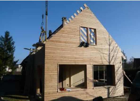
Chantier Extérieur Extension
