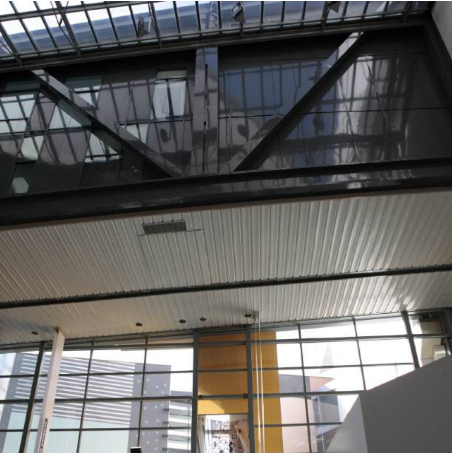
Détail Poutre Traversante
