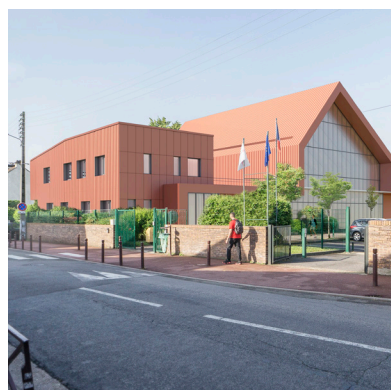
2018 | Étude + PC | Construction d'un gymnase, extension et rénovation d'un CFA | Ermont (95) | MOA Privé
