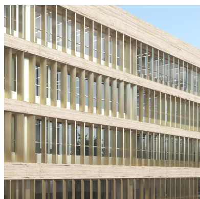
2013 | Projet de Fin d'Étude | Réhabilitation de la dalle du pont de Sèvres | Boulogne-Billancourt (92) | MOA Privé
