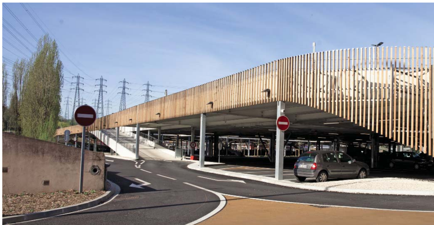
▲ VUE DU PARKING SILO - ANGLE OUEST
