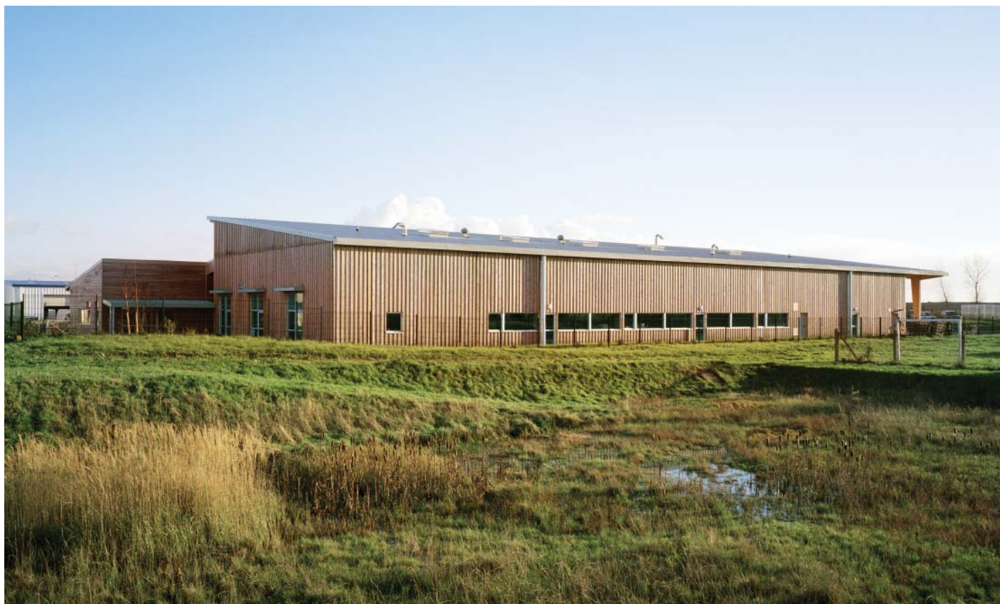
▲ VUE OUEST DE PUIS LA PRAIRIE INONDABLE
