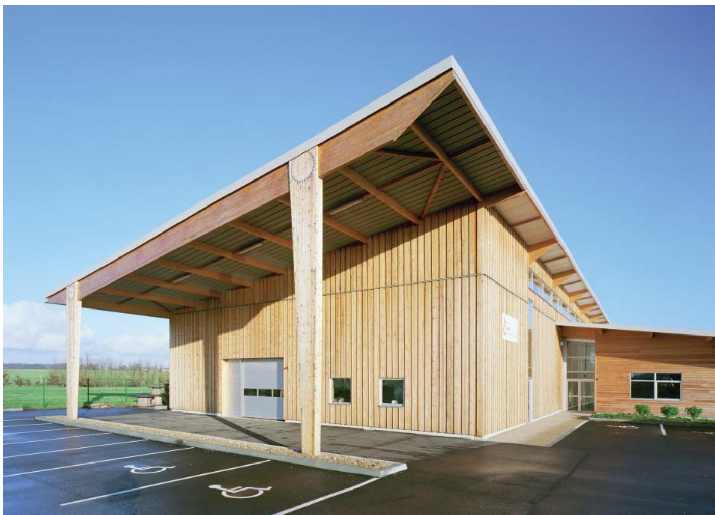
▼ VUE DU PORCHE LOGISTIQUE ET DE LE LA SÉQUENCE D'ENTRÉE
