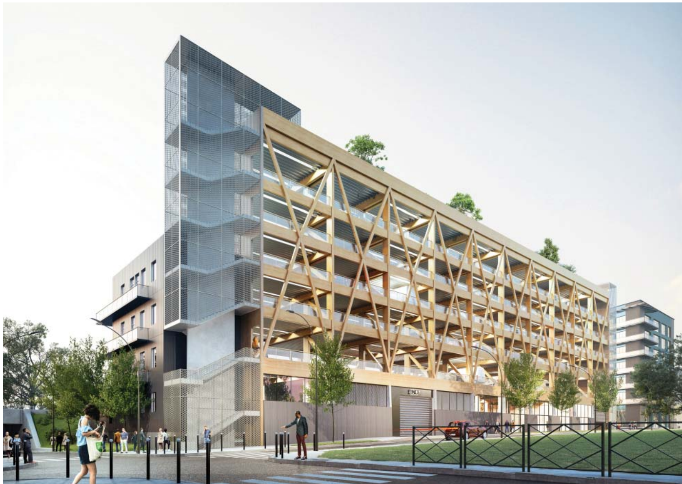
▲ VUE DU LOT CD - PARKING SILO + LOCAUX D'ACTIVITÉS + BRIGADE SNCF
