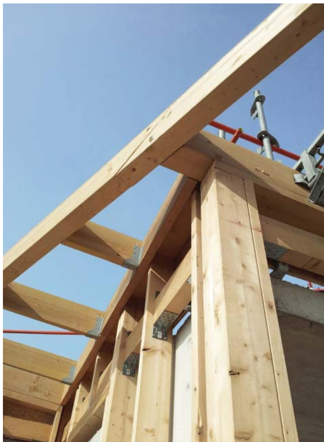
▼ DÉTAIL DE CHARPENTE ET MUR OSSATURE BOIS
