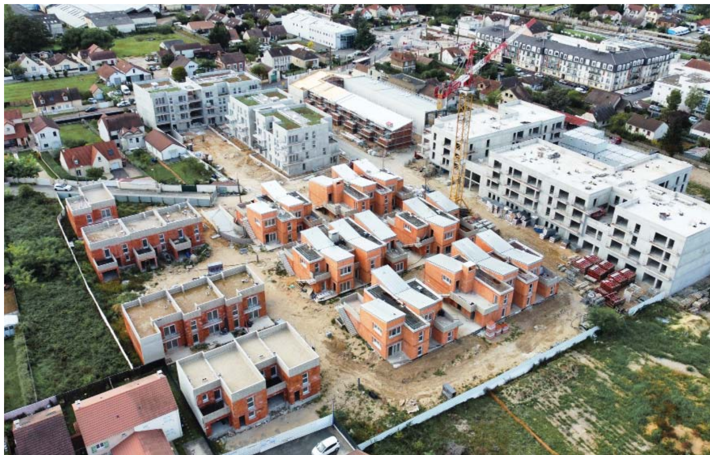
VUE AÉRIENNE DU CHANTIER EN COURS ▼
