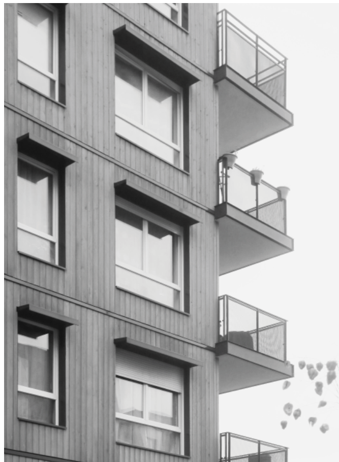
▼ DÉTAIL DE FAÇADE
