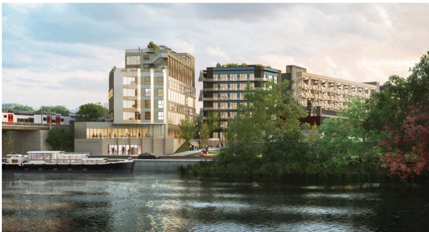
▼ VUE DEPUIS LES BERGES SUD
