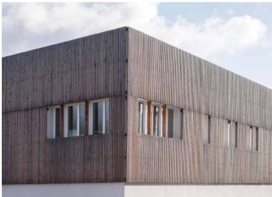
▼ DÉTAILS DE FAÇADES DU PÔLE ADMINISTRATIF
