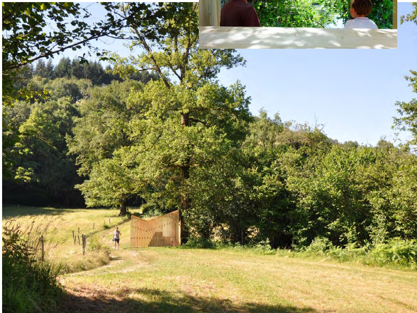
Vue de la cabane construite
