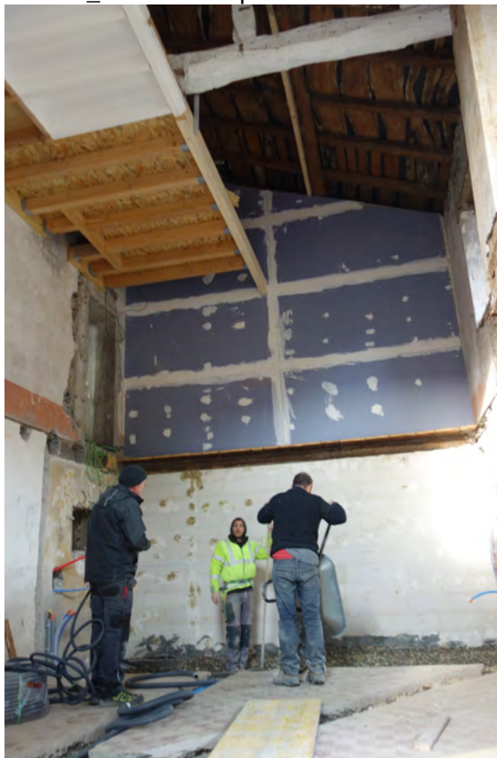
Aile Est _ réfection du plancher intermédiaire
