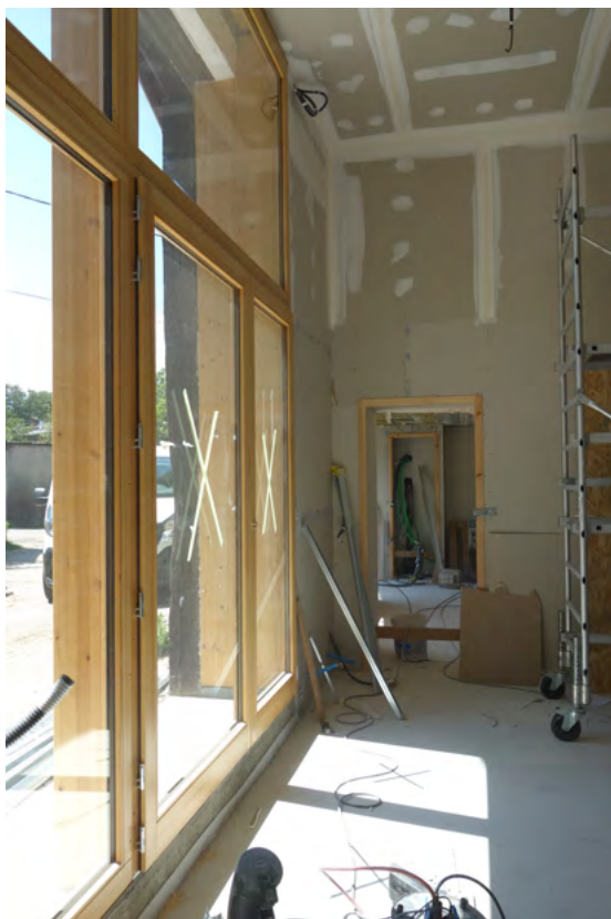
Aile centrale _ L'ouverture de 12m 2
