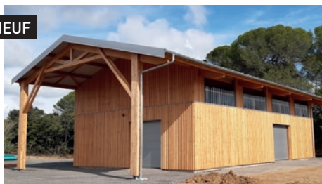
Hangar Agricole l'Auribelle
