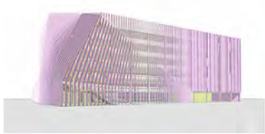
Façade polychrome cinétique
