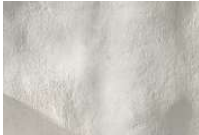
→ Enduit à la chaux
