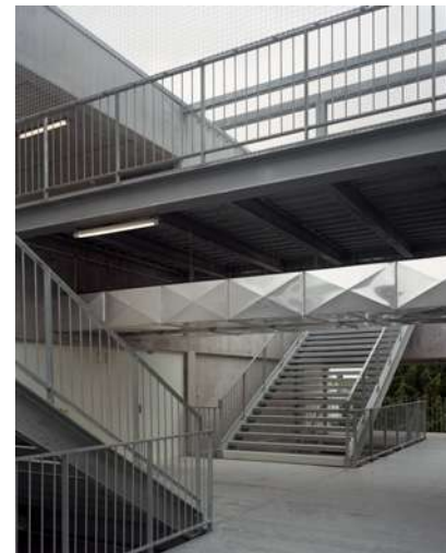
→ Escalier central ext.- Charpente acier galva
