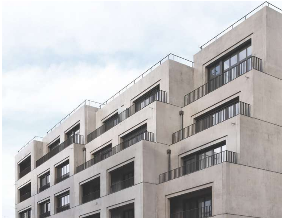
→ Façade Ouest en béton lasuré
