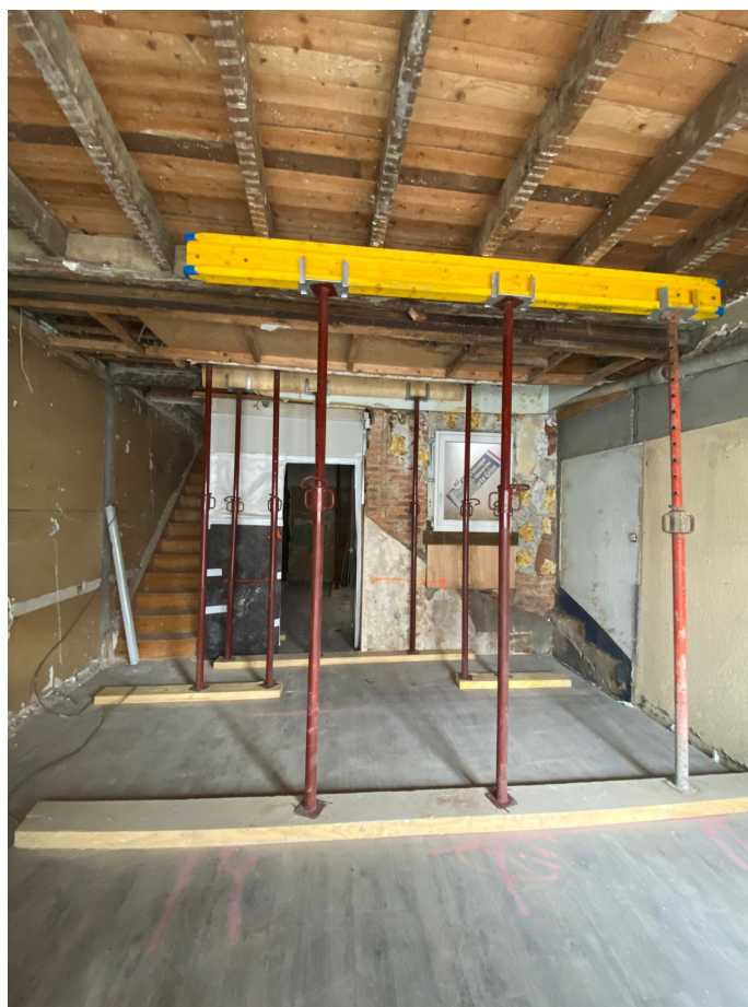
Après curage : mise à jour de désordres structuraux importants, mise en œuvre de renforts temporaires avant travaux
