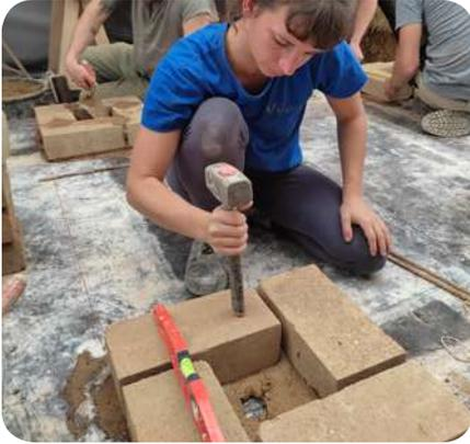
Dans le cadre de l'exercice pratique du **MONTAGE DES PILIERS ET VOÛTES** en BTC, **des briques sèches sont utilisées** (non celles fabriquées la veille). Ces briques n'ont pas été découvertes car le célophane n'a pas été retiré. Elles sont donc légèrement trop humides et effritables. Leurs arêtes sont pour certaines cassées. Le montage est ainsi rendu plus difficile.
