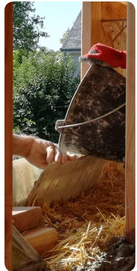
La **double ossature bois porteuse** est conçue pour enchâsser les bottes de paille et servir de support au coffrage pour la phase coulage. L'orientation longitudinale des poteaux est unique au regard des pratiques courantes de la construction bois.
