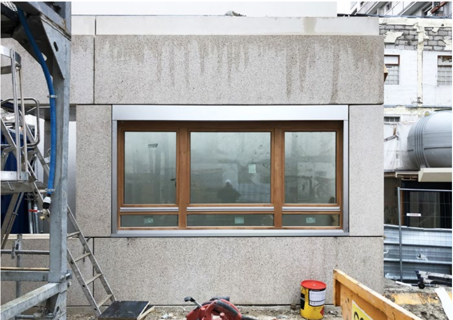
Photo 1 : prototype de façade en béton préfabriqué porteur finition sablé, menuiserie bois et habillage aluminium
