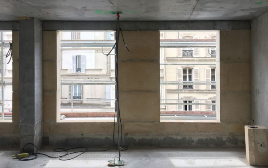
Photo 3 : façade en pierre massive auto-porteuse avec ossature béton poteaux-dalle indépendante
