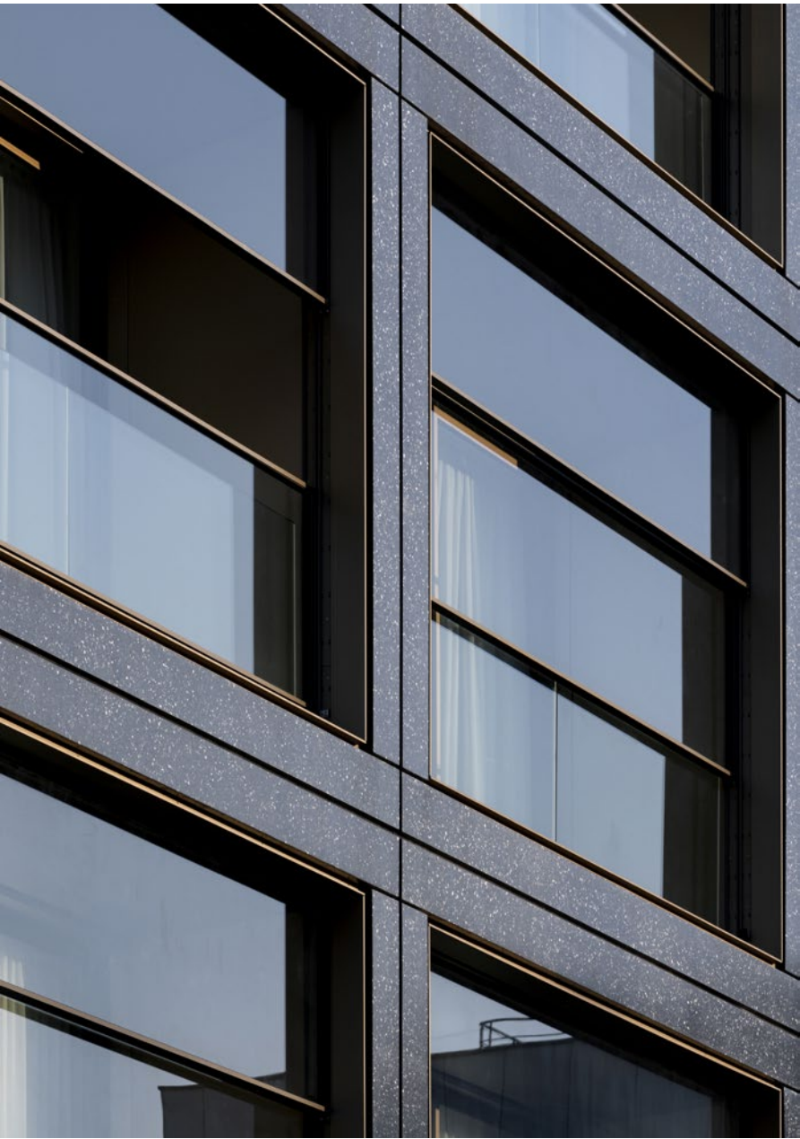
Photo 2 : vue sur les jardins d'hiver en menuiseries à guillotine aluminium anodisé
