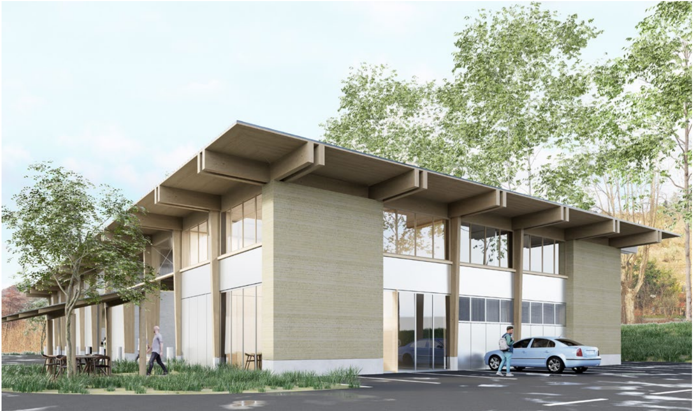
Image 2 : Murs pignons réalisés en terre compactée in situ
