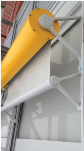
Façade double-peau ventilée avec stores automatisées intégrées Performance acoustique 40 OITC ~45dB - 2015 Best Facade
