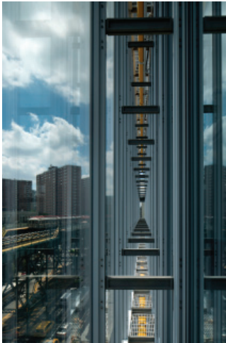
Façade double-peau ventilée avec stores automatisées intégrées Performance acoustique 40 OITC ~45dB - 2015 Best Facade
