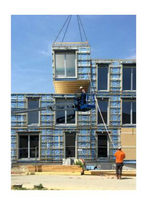
Entièrement conçu en modules 3D bois, assemblés en atelier, les finitions y sont aussi réalisées et les équipements posés. L'ensemble du projet est calibré sur les gabarits routiers. La dépense carbone des convois est largement compensée par le bilan carbone du projet: terrassement
