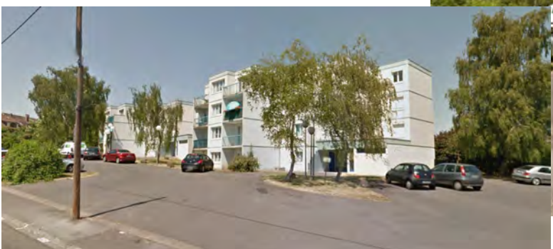
Vue avant réhabilitation
